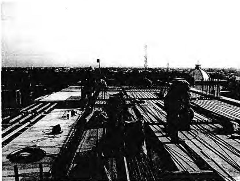
Gambar 1.10 pembersihan, bekisting plat dan balok
