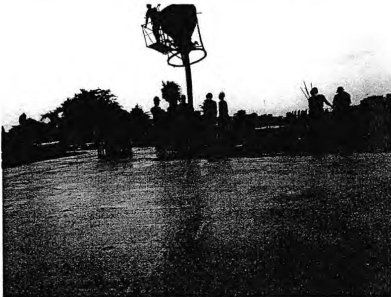
Gambar 1.6 pengecoran plat lantai dan balok menggunakan bucket
