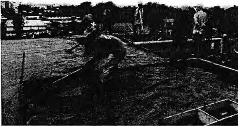
Gambar 3.11.5 Pengecoran Plat Lantai
