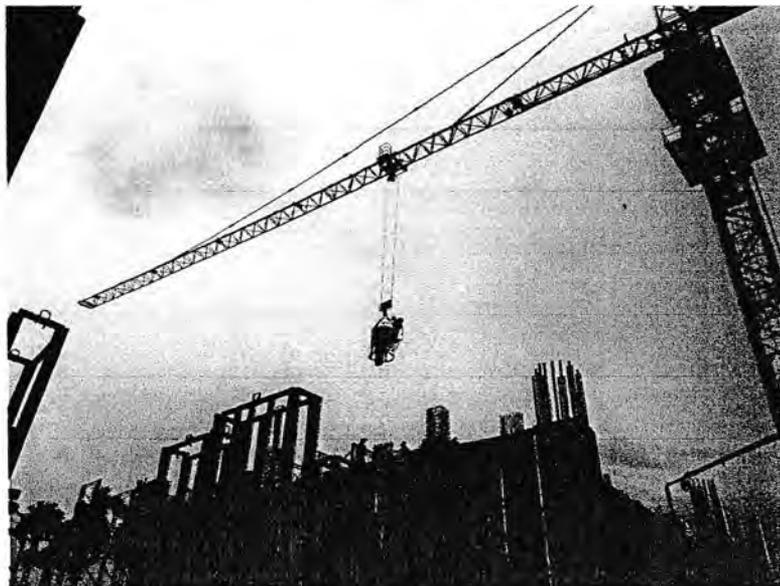
Gambar 1.4 tower crane membawa beton menggunakan bucket
