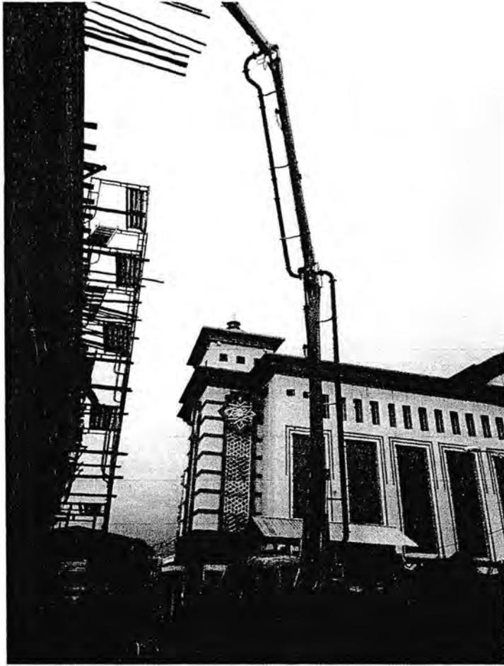
Gambar 1.5 Pump Concrete untuk pengecoran plat dan balok
