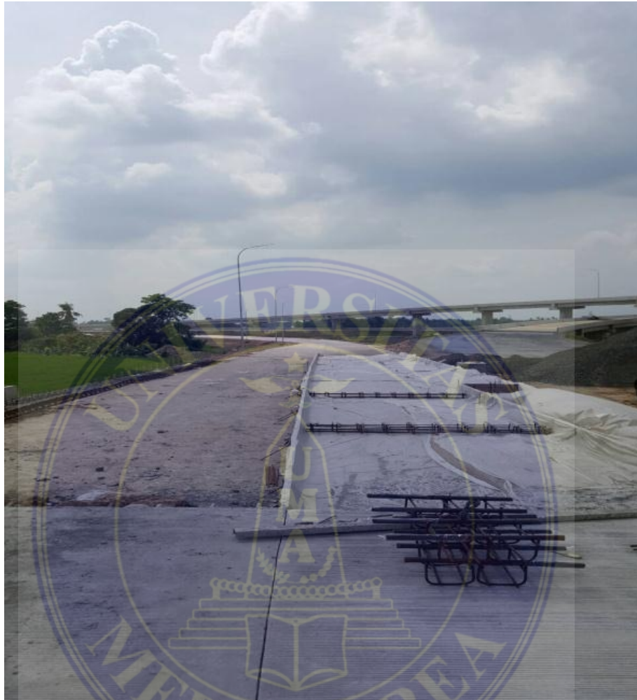
Gambar 1 Pemasangan Dowel
