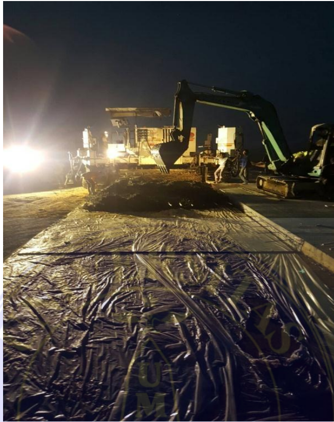
Gambar 4 Pemerataan Lean Concrete dengan Excavator
