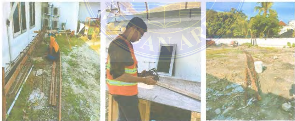
Gambar 3.8. Pekerjaan Pembesian Pondasi Tapak, Kolom, dan Sloof
