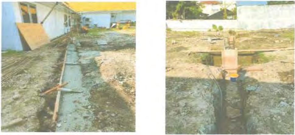
Gambar 3.9. Pekerjaan Bekisting dan Pengecoran
