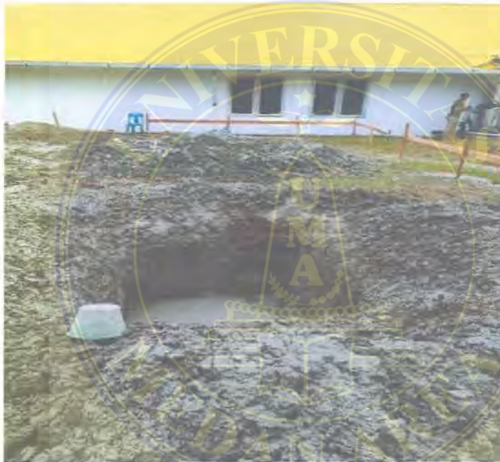
Gambar 3.3. Pekerjaan Galian Pondasi
