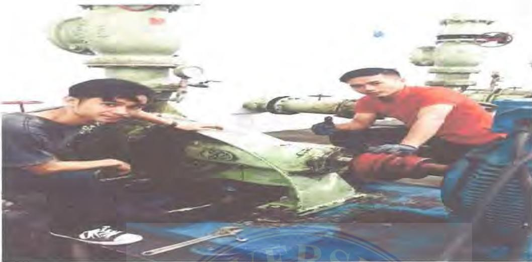
Gambar 3.12. Pemasangan Pipa Saluran Baru
