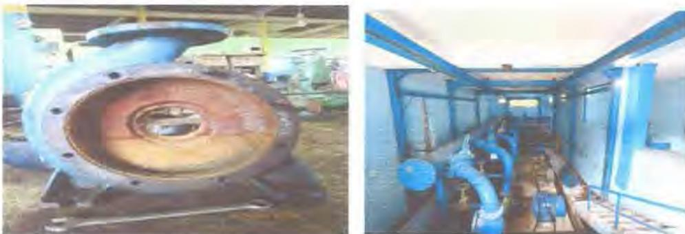
Gambar 3.13 Pompa Sentrifuga
