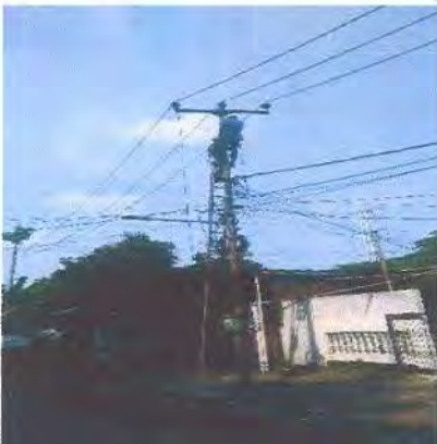
Gambar 3 8 Sesudah Perbaikan Traves
