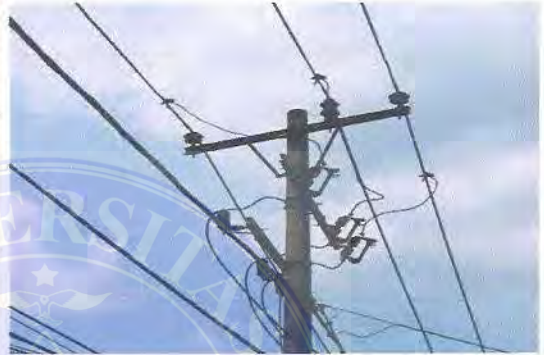
gambar 3.13 etelah pemasangan pin isolator
