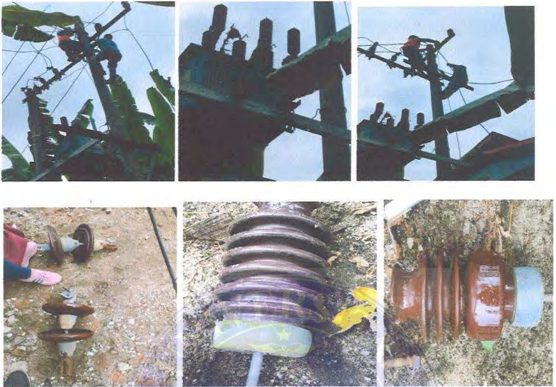
Gambar 6.1 Pelepasan/Pembongkara Komponen JTM 20Kv
