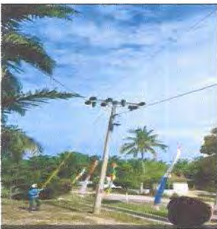
Gambar 8.3 pelepasan FCO untuk jaringan udara dari pelepasah pohon
