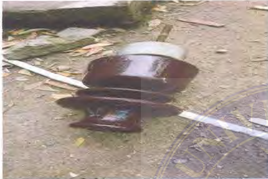
Gambar 3.12 Mengganti Pin Isolator
