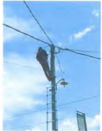
Gambar, 3.6. penyaluran kabel SR 4 kawat, ke kWh meter 3 fasa
