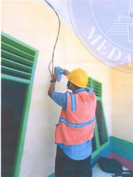
Gambar, 3.2. pemasangan kWh meter
