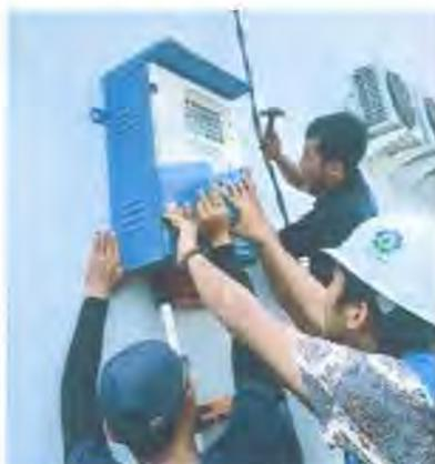
Gambar 3.8 proses pemasangan kWh meter 3 fasa
