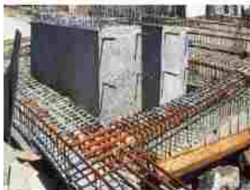
Gambar 5.9. Struktur Tiang Beton Bertulang (Sumber: analisa pribadi)
