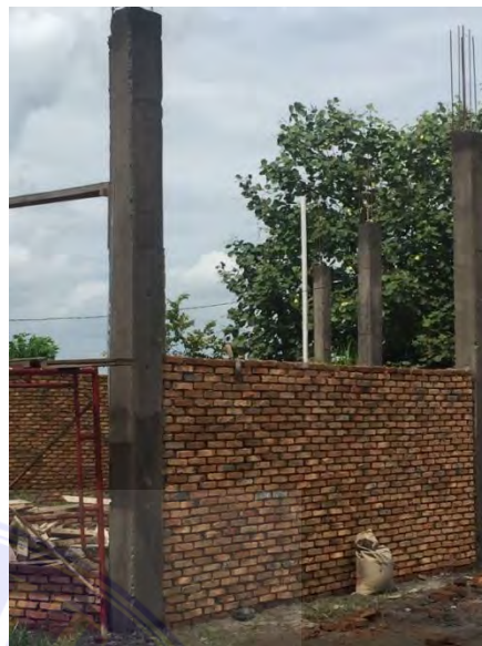
Pemasangan ½ Bata
