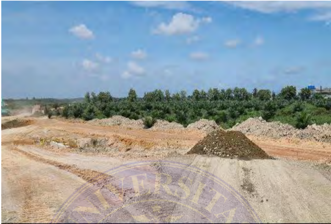
Gambar 6 Peletakan Material Tanah
