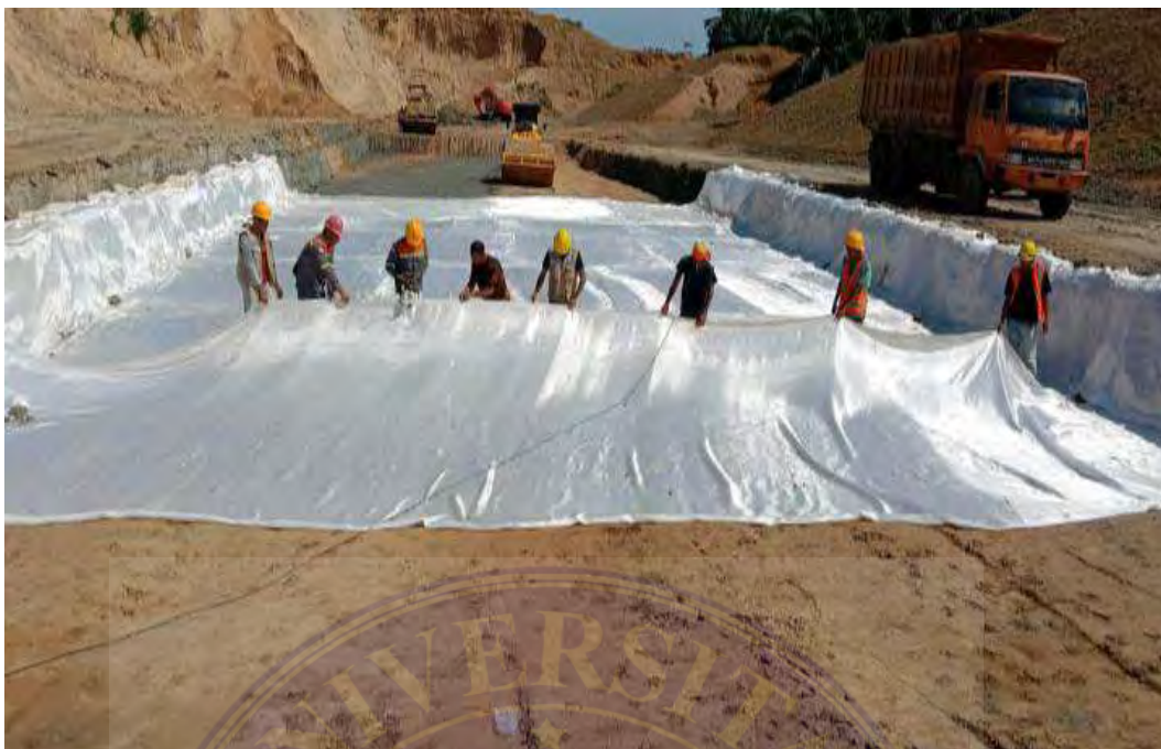
Gambar 8 Pelapisan Sebelum di Cor
