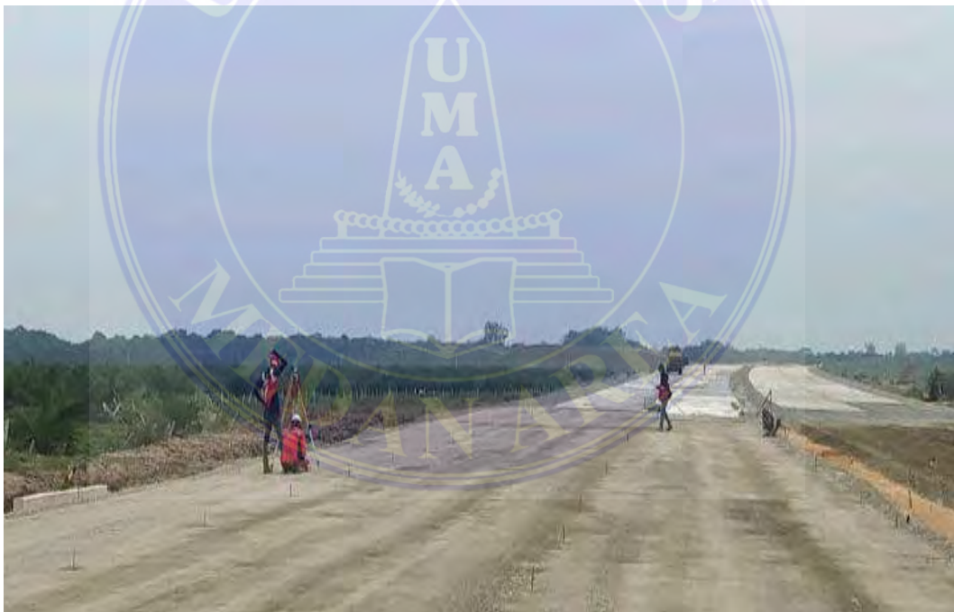
Gambar 7 Pengukuran Kembali Elevasi
