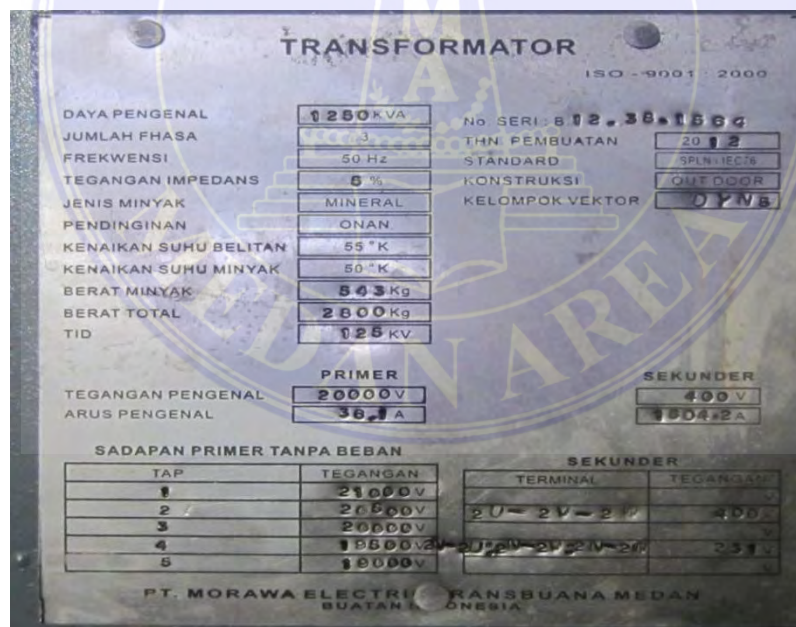
Gambar 3. 11 Name Plate Trafo 2, Trafo 4, Tarfo 5, dan Trafo 7
