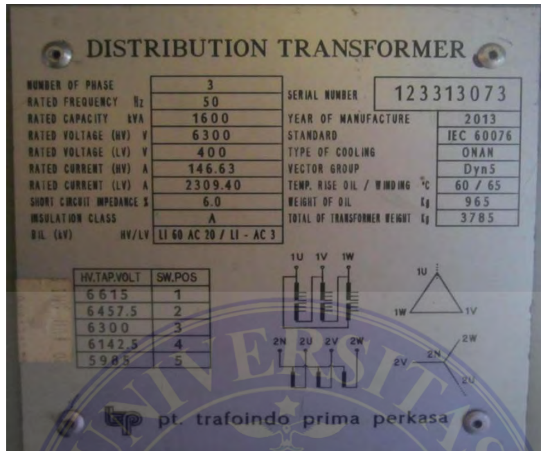
Gambar 3. 11 Name Plate Trafo 2, Trafo 4, Tarfo 5, dan Trafo 7
