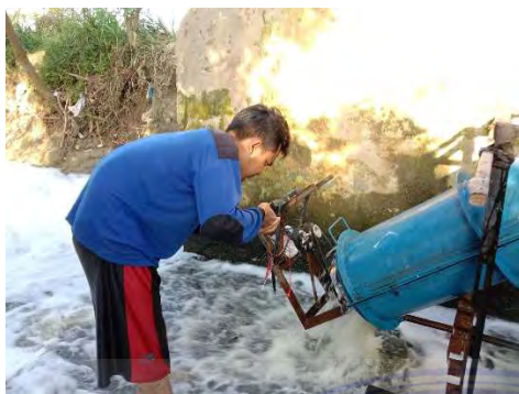
Gambar 3.12 Pengukuran Putaran Generator
