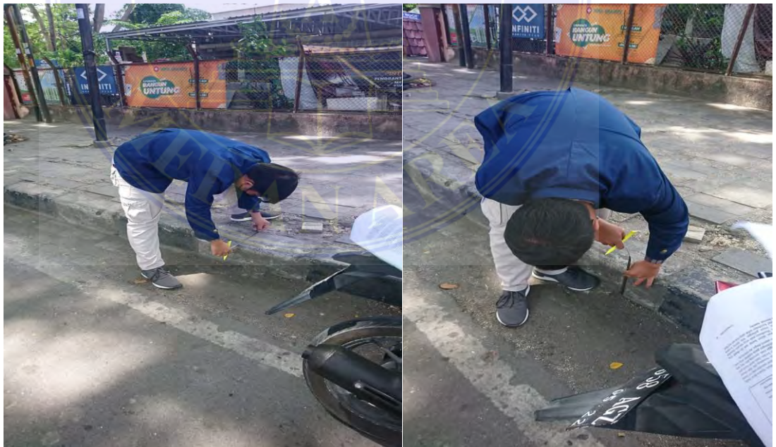
Gambar 3.e Kerb Pada jalan Gatot Subroto (Sp. Iskandar Muda- Sp. Ayahanda)
