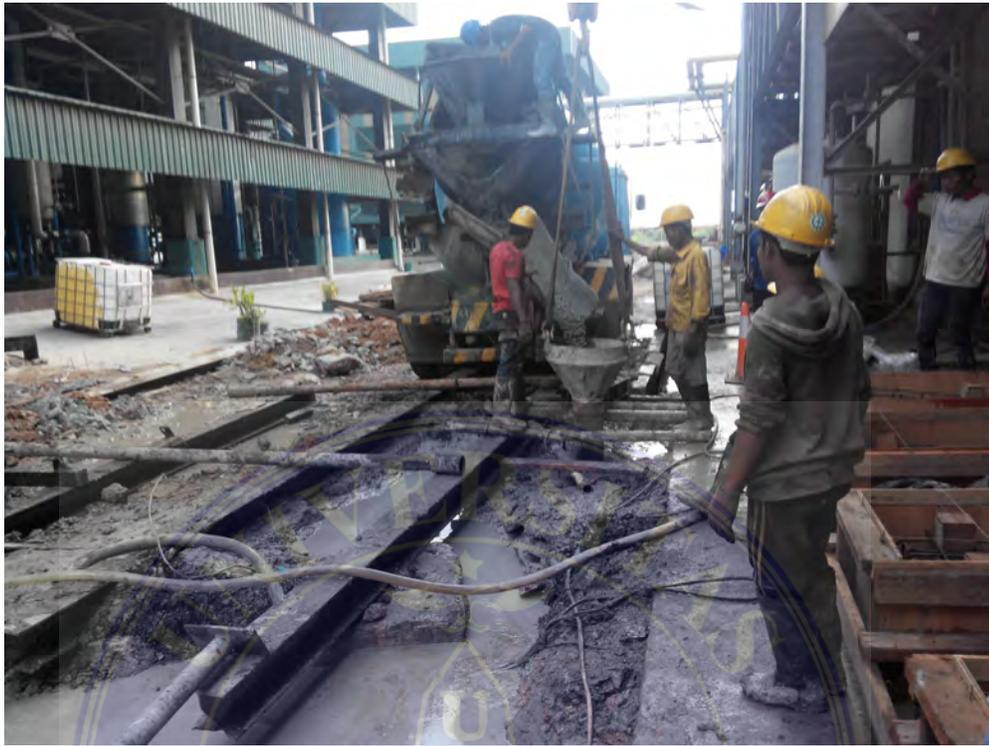
Gambar. Proses Pengecoran Pondasi
