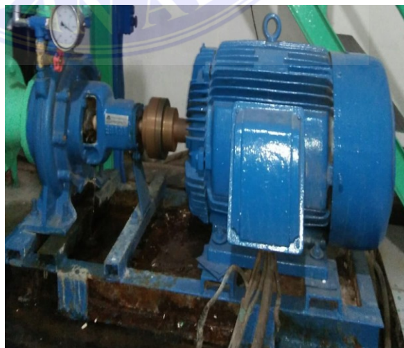
Gambar 3.6. Pompa Sentrifugal
