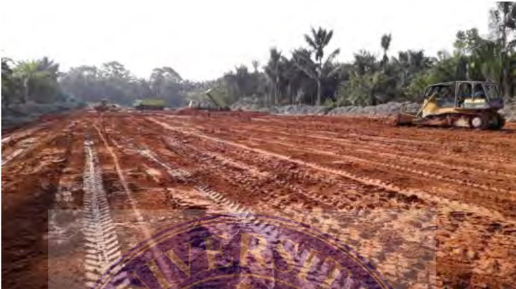
“Proses perataan tanah dengan *bulldozer*”
