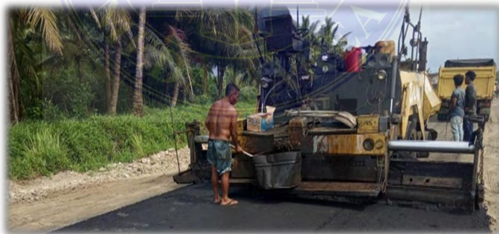
“Penghamparan Aspal Dengan Menggunakan Alat Asphalt Finisher”
