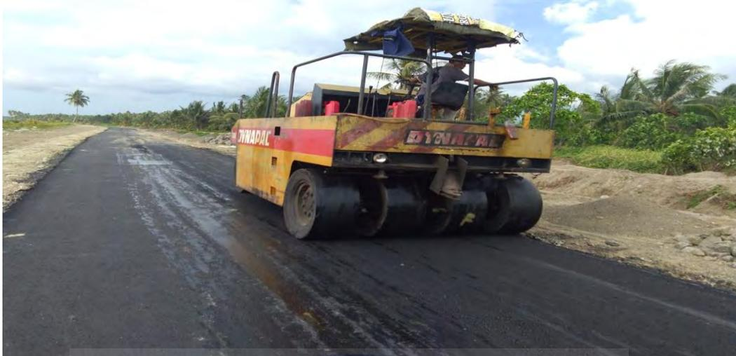
Gambar 2.4 *Pneumatic Tire Roller*
