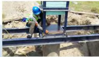
Gambar 3.6 Penempatan Cusshion pada tiang
