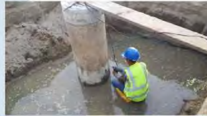
Gambar 2.2 Pengeboran lubang angkur sensor
