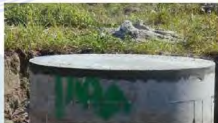
Gambar 1.8 Hasil akhir grouting kepala tiang
