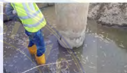
Gambar 2.4 Pemasangan mal sensor
