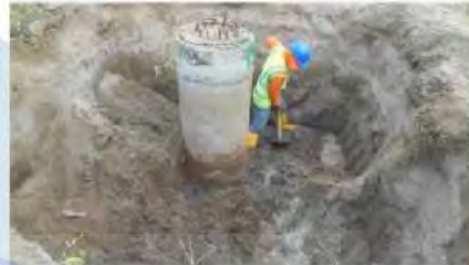
Gambar 1.2 Pembersihan tanah pada badan tiang
