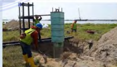
Gambar 3.4 Penempatan Hammer 5 Ton pada tiang
