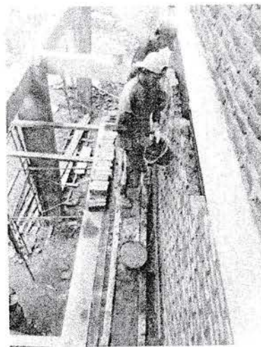
Gambar 7. Proses Pemasangan Memasang Dinding Bata
