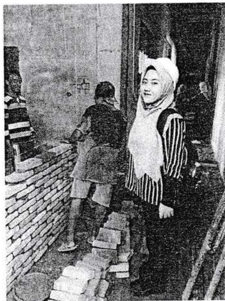
Gambar 4. Proses Pemasangan Dinding Campuran Pasir dan Semen (mortar)
