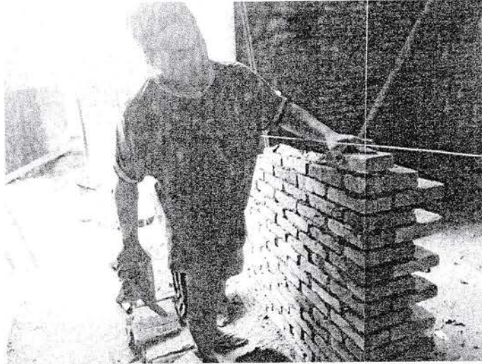
Gambar 2. Pemasangan Dinding Dengan Menarik Benang. Pemasangan Dilakukan Diatas Lantai Kerja
