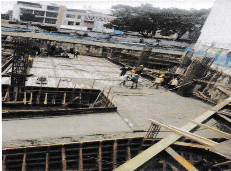
Gambar 4.6. Proses Pengecoran Lantai Dan Kolom
