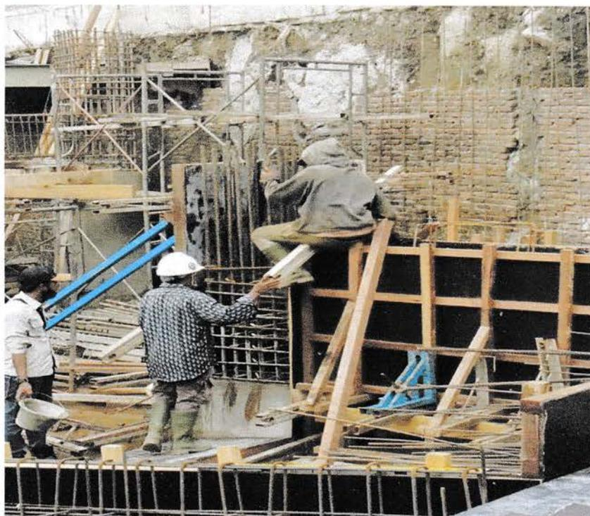
Gambar 4.5. Pembuatan Bekisting
