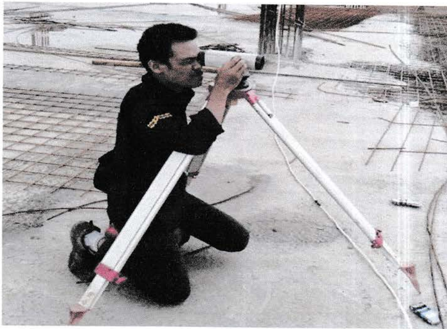
Gambar 4.2.2 Pengukuran ketinggian plat lantai
