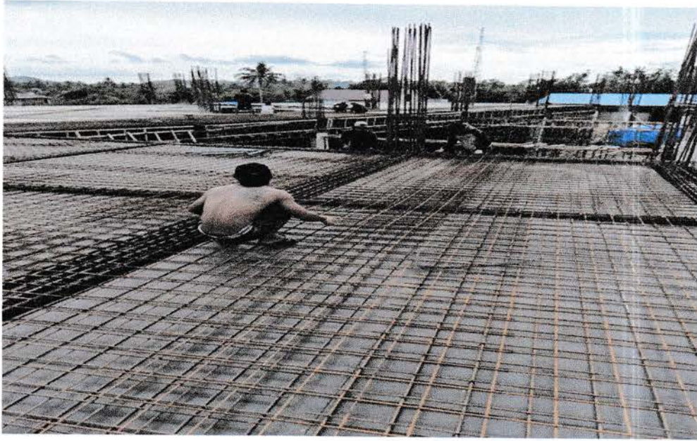
Gambar 4.2.2 a)Pengikatan besi ikat b)Pemasangan besi ikat diantara kolom (Sumber: Data lapangan)
