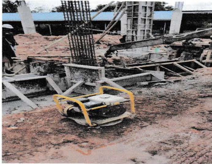
Gambar 3.4 Vibrator pemadat beton
