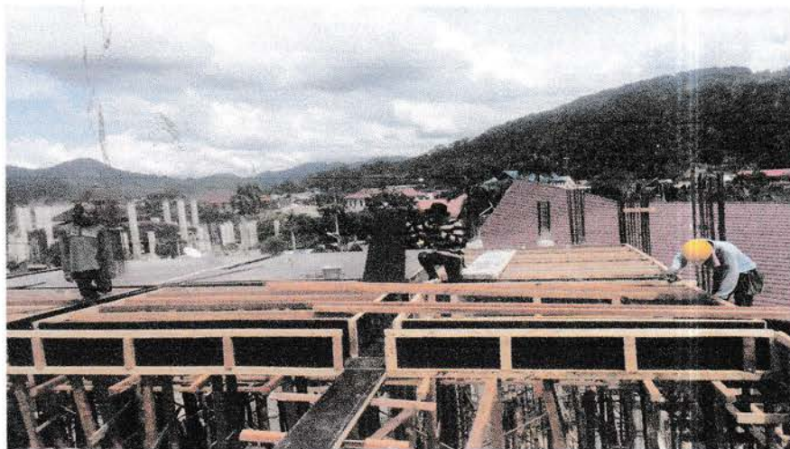
Gambar 4.2.3 a)Pemasangan u-head,suri-suri dan hollow
