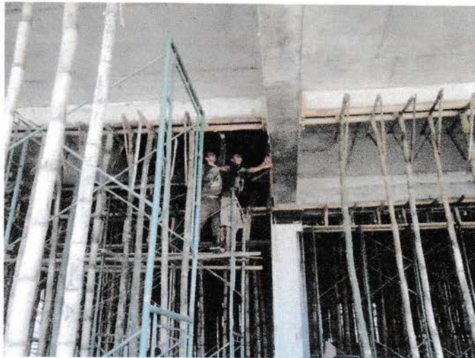
Gambar 4.2.6 Pekerjaan Pembongkaran Bekisting
