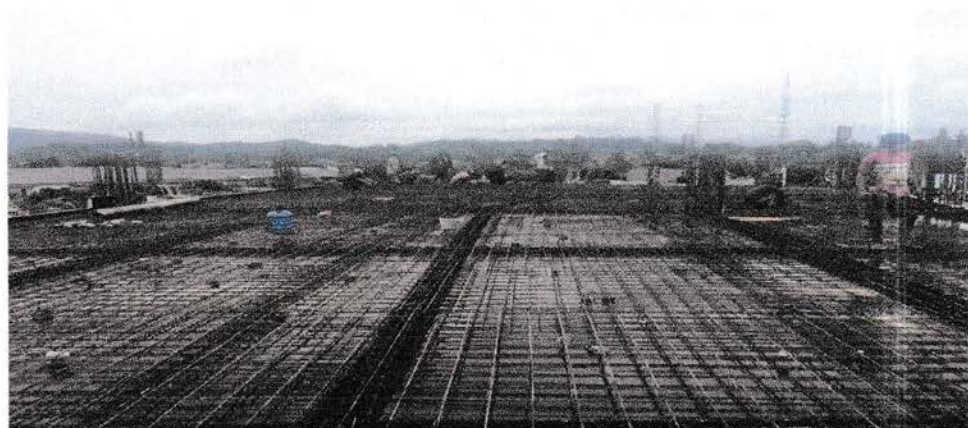
Gambar. 4.2.4 a) Pemasangan plywood b) pembersihan area
