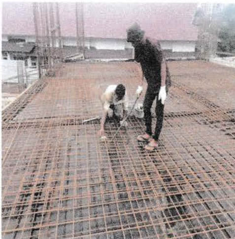
Gambar 4.2.4 a)Pemasangan beton deking b)Pemasangan beton deking pada balok
