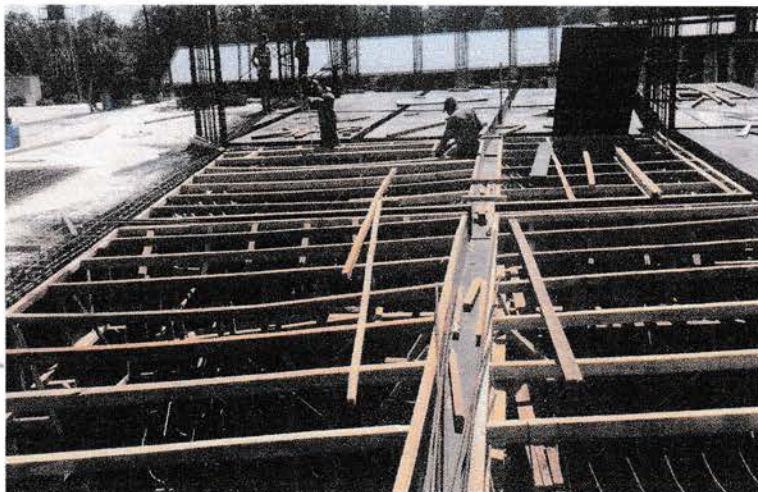
Gambar 3.3.3 Struktur Plat lantai
