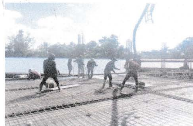
Gambar 4.2.5 a)Pengecoran pada plat b)Pengecoran pada balok c)Perkuatan sebelum pengecoran
