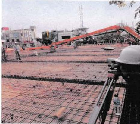
Gambar 4.1 Pengukuran ketinggian plat lantai
