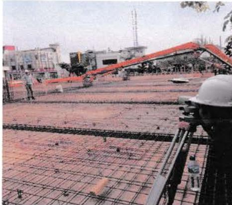
Gambar 4.1 Pengukuran ketinggian plat lantai
