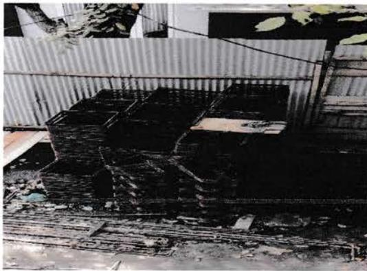
Gambar 4.8 Pembesian untuk begel kolom
