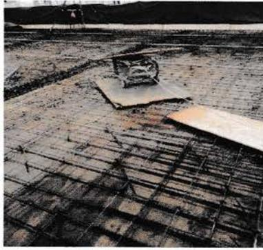
Gambar 3.2 Vibrator pemadat beton
