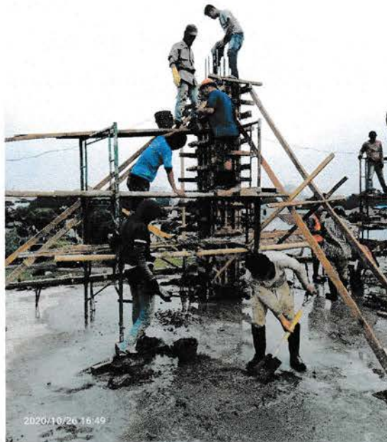
Gambar 4.43 Pengecoran kolom Sumber : Lokasi proyek
