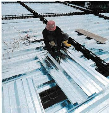
Gambar 4.50 Pemasangan baja ringan Sumber : Lokasi proyek
