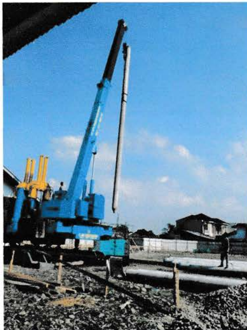
Gambar 4.21 Drop hammer Sumber : Lokasi proyek
