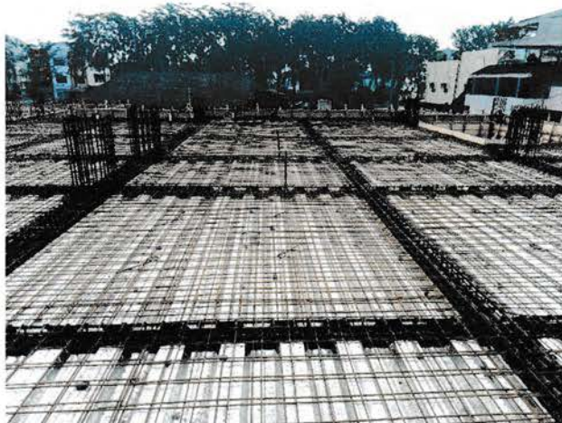
Gambar 4.52 Susunan tulangan plat lantai Sumber : Lokasi proyek
