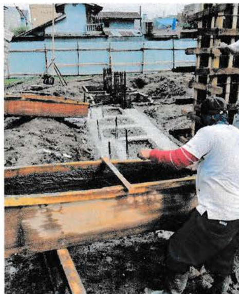
Gambar 4.49 Pengecoran balok Sumber : Lokasi proyek
