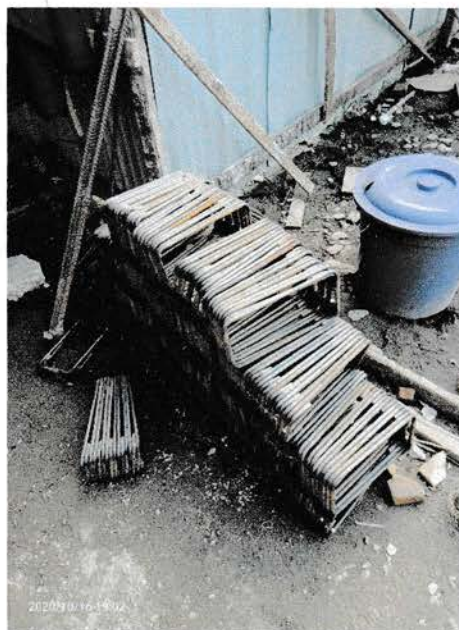
Gambar 4.40 Tulangan besi Sumber : Lokasi proyek
