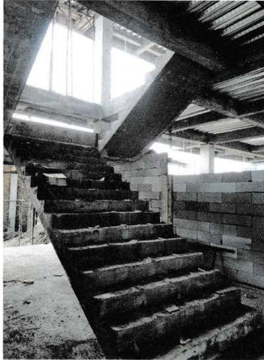
Gambar 4.58 Setelah lapisan cetakan dibuka Sumber : Lokasi proyek
