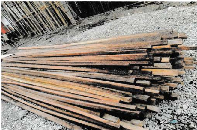
Gambar 4.14 Kayu Sumber : Lokasi proyek
