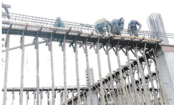
Gambar 4.45 Pemasangan scaffolding Sumber : Lokasi proyek
