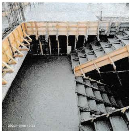
Gambar 4.57 Pengecoran tangga Sumber : Lokasi proyek
