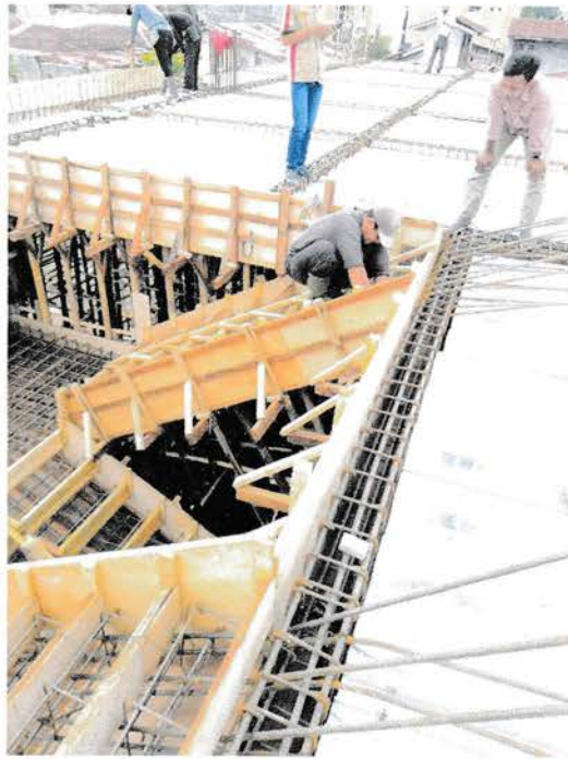
Gambar 4.56 Penulangan tangga Sumber : Lokasi proyek
