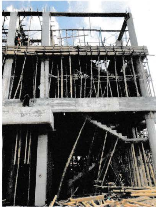
Gambar 4.55 Pemasangan tiang perancah Sumber : Lokasi proyek
