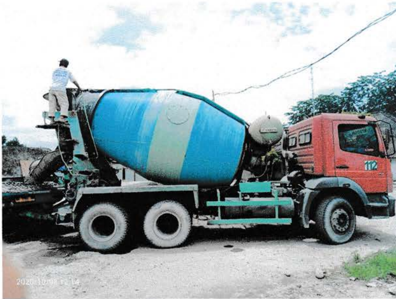
Gambar 4.11 Beton ready mix Sumber : Lokasi proyek
