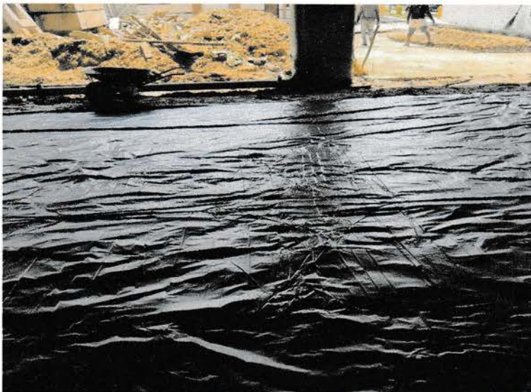
Gambar 4.20 Geotekstil Sumber : Lokasi proyek
