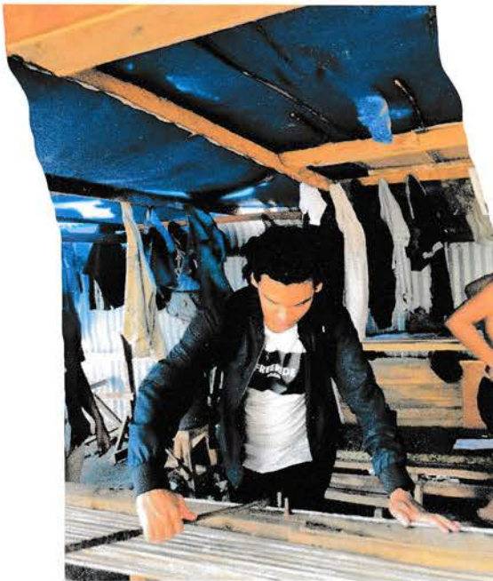
Gambar 4.39 Pembengkokkan tulangan Sumber : Lokasi proyek
