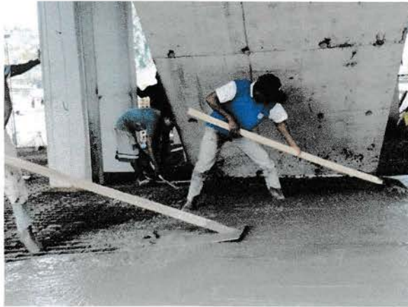
Gambar 4.54 Proses pemerataan Sumber : Lokasi proyek
