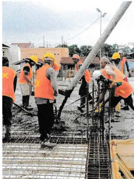
Gambar 4.53 Pengecoran plat lantai Sumber : Lokasi proyek
