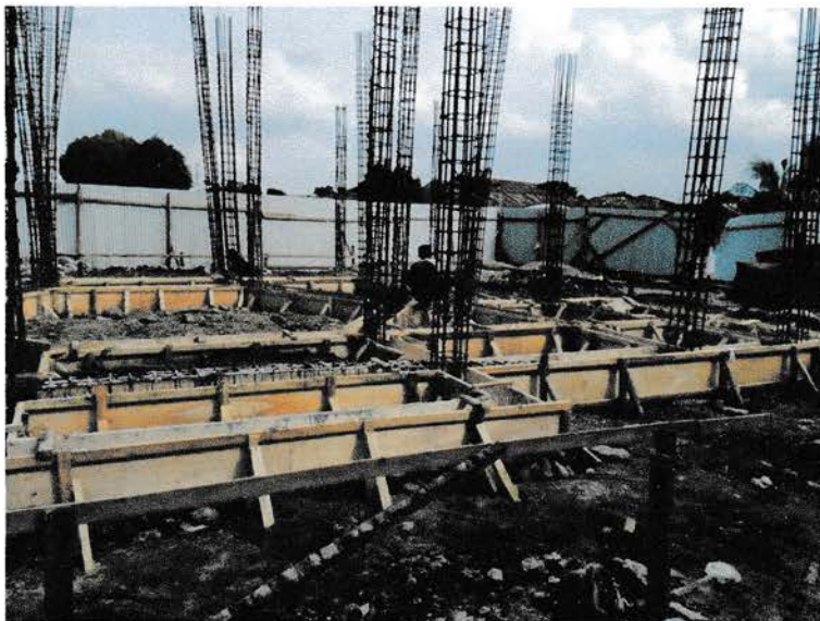
Gambar 4.41 Pemasangan kolom Sumber : Lokasi proyek
