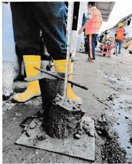
Gambar 4.48 Nilai uji slump Sumber : Lokasi proyek
