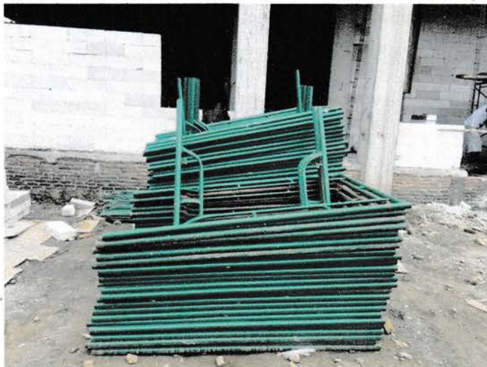
Gambar 4.26 Perancah Sumber : Lokasi proyek
