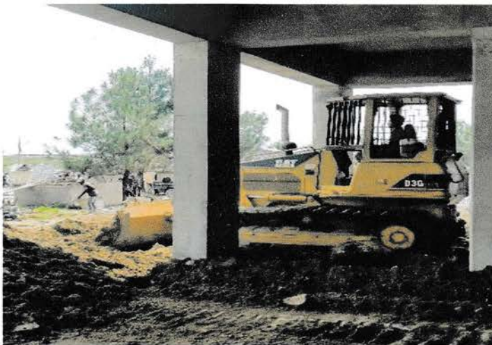
Gambar 4.28 Crawler dozer Sumber : Lokasi proyek
