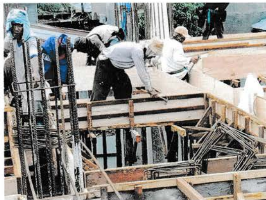
Gambar 4.46 Pemasangan komponen cetakan balok Sumber : Lokasi proyek
