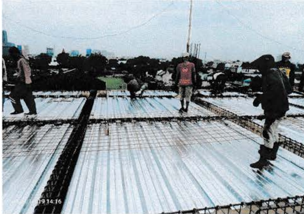
Gambar 4.51 Pemasangan tulangan Sumber : Lokasi proyek
