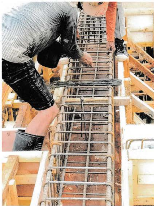
Gambar 4.47 Pemasangan komponen balok Sumber : Lokasi proyek
