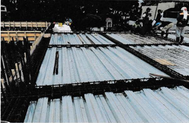
Gambar 4.19 Bondek Sumber : Lokasi proyek
