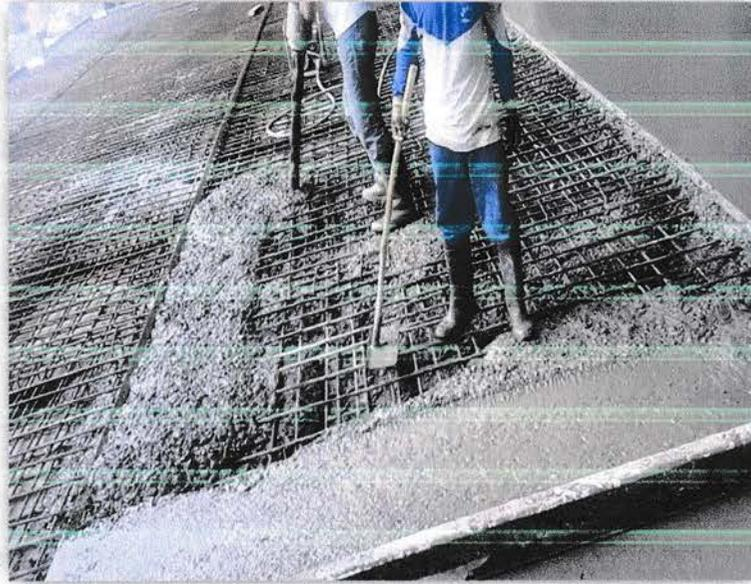
**Gambar 4.27** Pengecoran Plat Lantai dengan Metode Cor Konvensional
