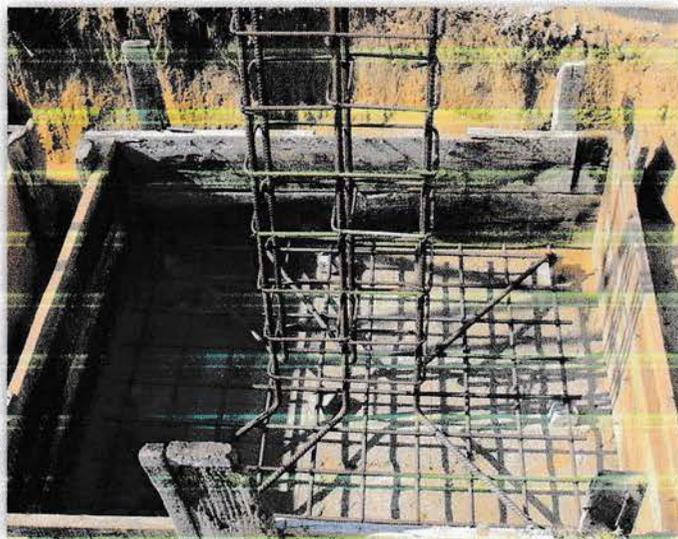
**Gambar 4.19** Pemasangan Bekisting *Pilecap*
