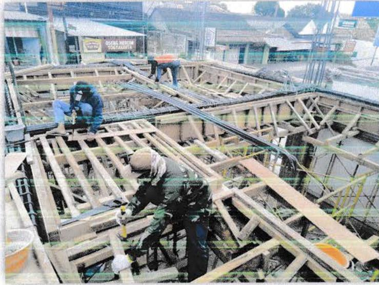
**Gambar 4.17** Pemasangan Bekisting Balok
