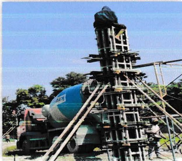
**Gambar 4.24** Penuangan Beton ke Bekisting Kolom
