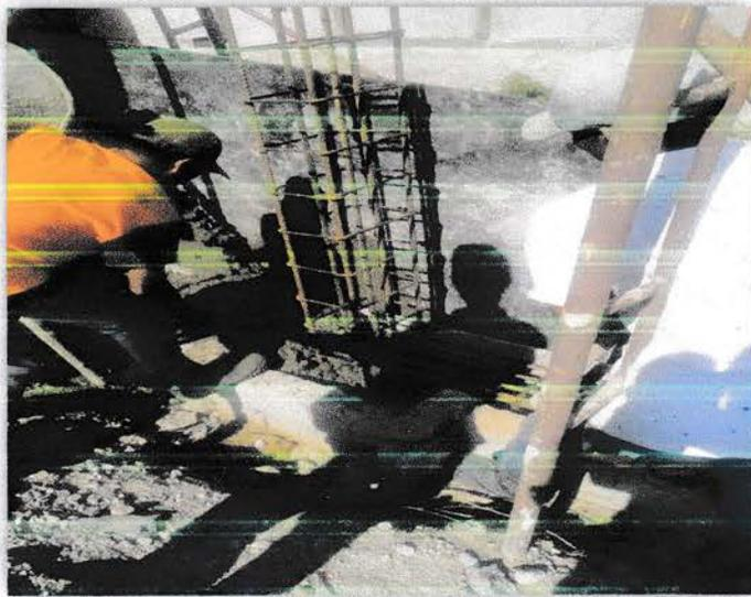
**Gambar 4.15** Pengecoran Balok Sloof
