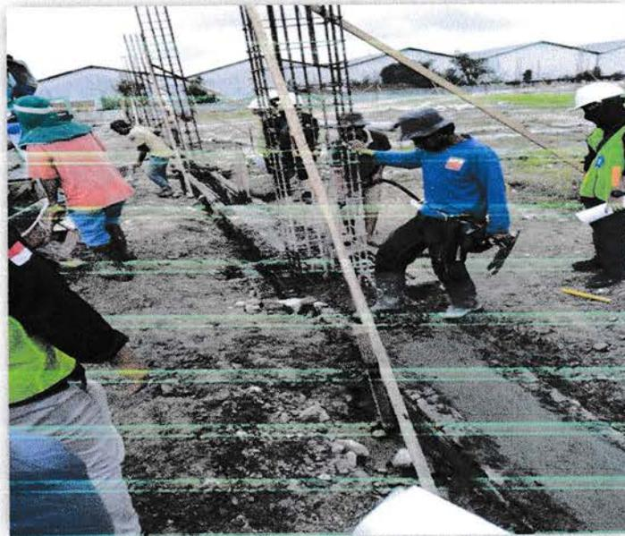
**Gambar 4.20** Pemasangan Tulangan Kolom
