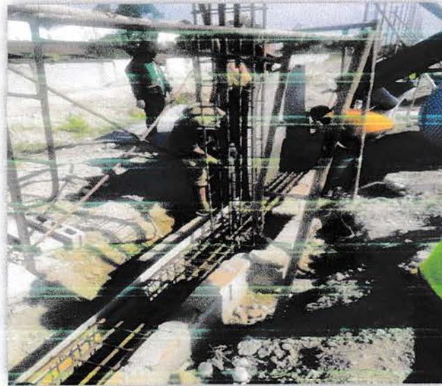
**Gambar 4.16** Pengecoran Balok Sloof
