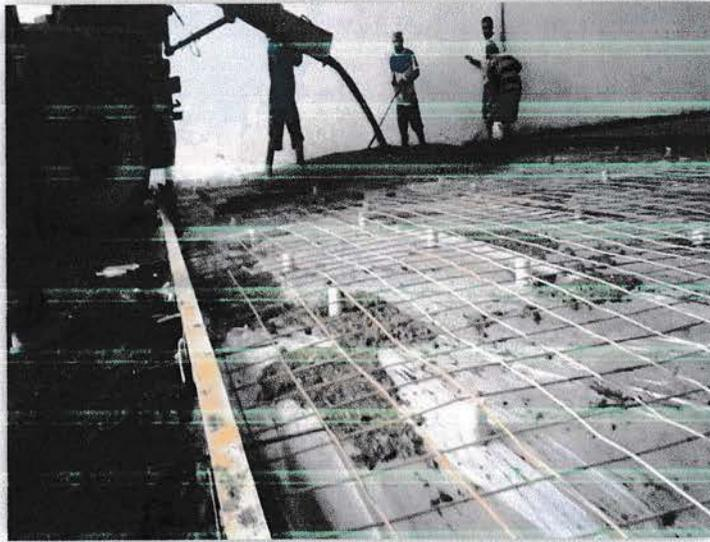
**Gambar 4.26** Pengecoran Plat Lantai dengan Metode Cor *Precast*
