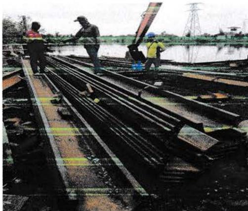
Gambar 3.14 Sheet pile baja
