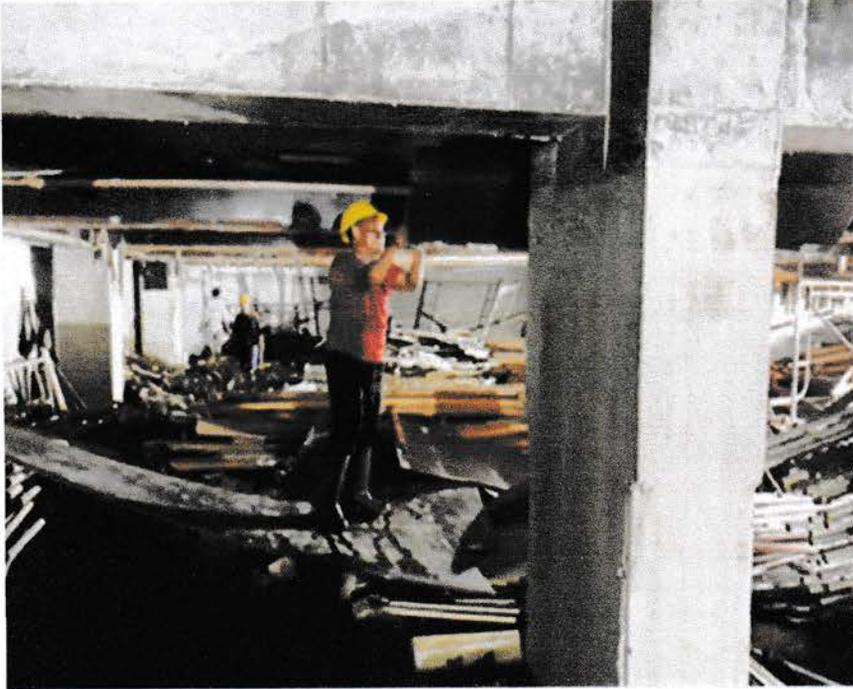
*Gambar 19. Pembongkaran bekisting*
