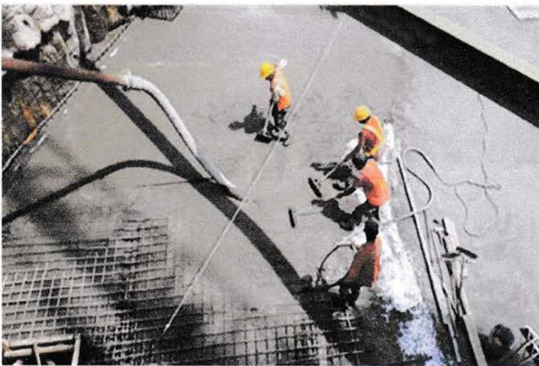
**Gambar 18. Pengecoran Lantai Basement**
