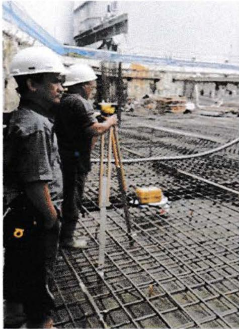
**Gambar 14. Theodolite dan Bak Ukur**
