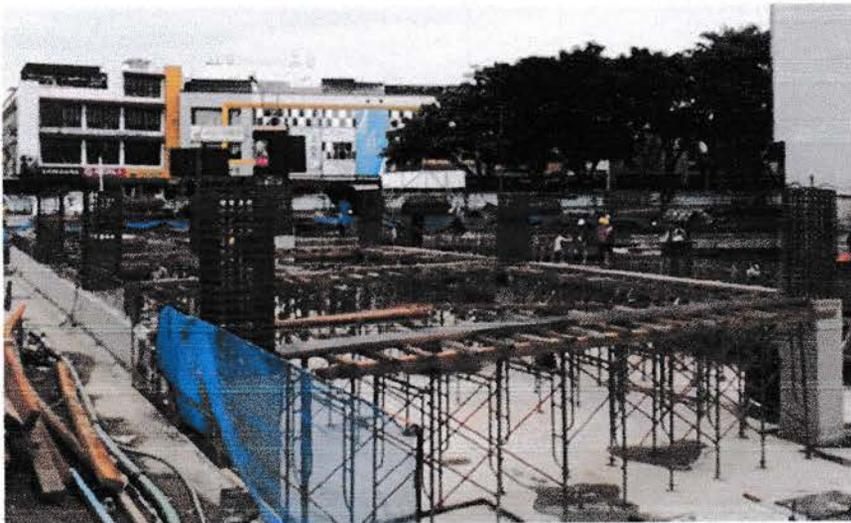
*Gambar 8.* pemasangan bekisting balok
