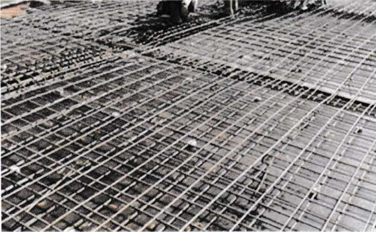
**Gambar 17. Tahu Beton (t:2,5 cm)**
