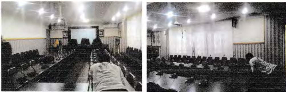
Gambar 1. Suasana Ruang Rapat Sebelum di Renovasi
