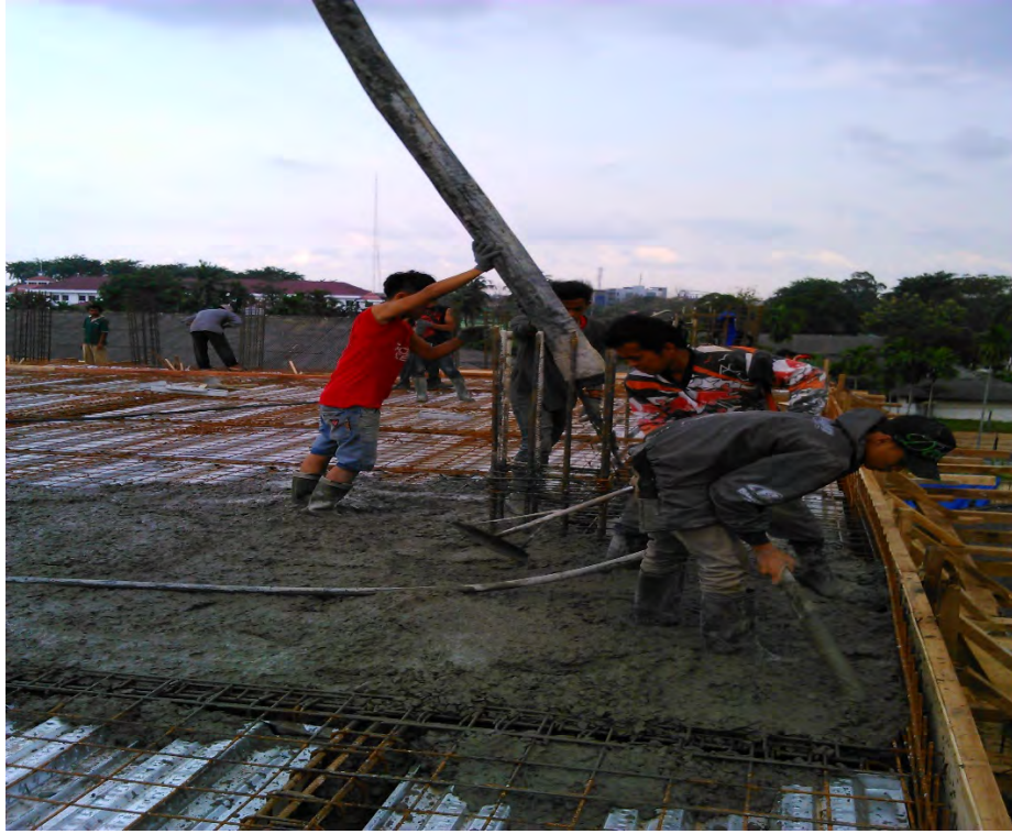
Gambar 13. Pengecoran Plat Lantai Lokasi : Jalan A.H. Nasution Kec.Medan , Medan
