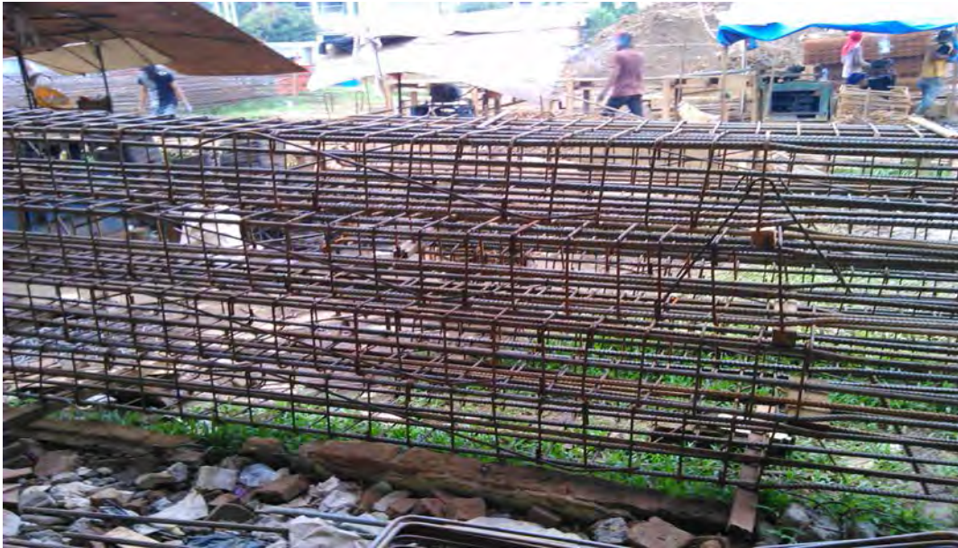
Gambar 3.4. Pekerjaan pemotongan dan pembengkokan tulangan
