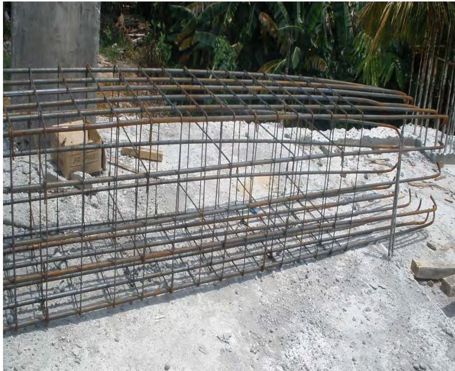
Gambar 4. Rangkaian Kolom
