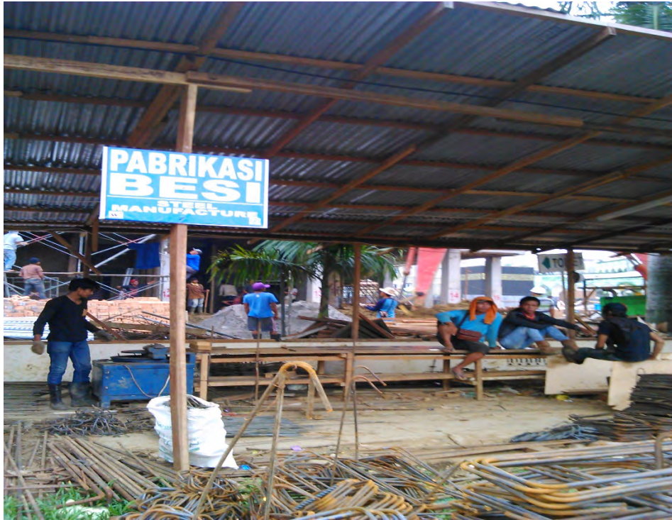
Gambar 17. Pabrikasi Besi Proyek Pembangunan Asrama Haji Medan Lokasi : Jalan A.H. Nasution Kec.Medan , Medan
