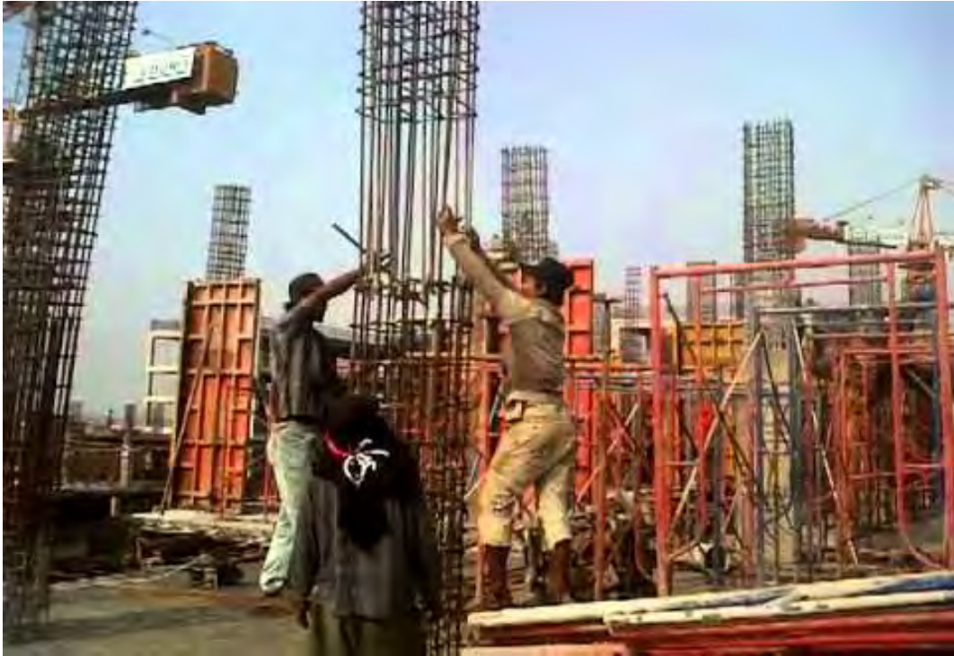
Gambar 3.1. Bekisting kolom
