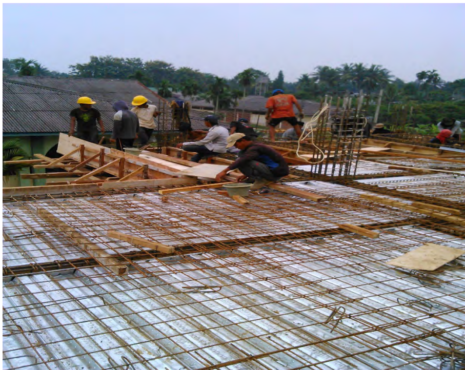
Gambar 12. Tulangan Plat Lantai yang sudah di pasang
