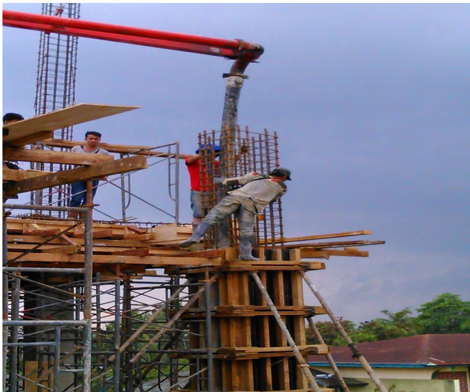
Gambar 8. Proses Pengecoran Kolom
