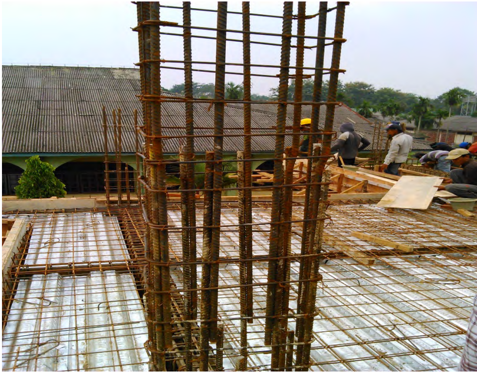
Gambar5 . Tulangan Kolom Yang Sudah Berdiri Lokasi : Jalan A.H. Nasution Kec.Medan , Medan
