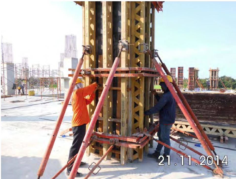
Gambar 6. Pemasangan Bakisting Kolom Lokasi : Jalan A.H. Nasution Kec.Medan , Medan
