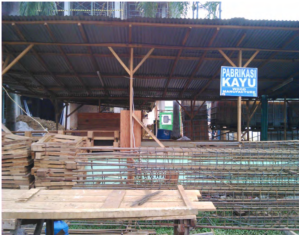
Gambar 18. Pabrikasi Kayu Proyek Pembangunan Asrama Haji Medan Lokasi : Jalan A.H. Nasution Kec.Medan , Medan
