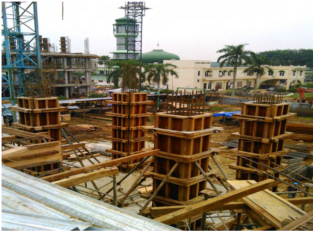
Gambar 9. Proses Pengeringan Kolom Lokasi : Jalan A.H. Nasution Kec.Medan , Medan
