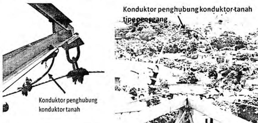
Gambar 29 Konduktor penghubung konduktor tanah
