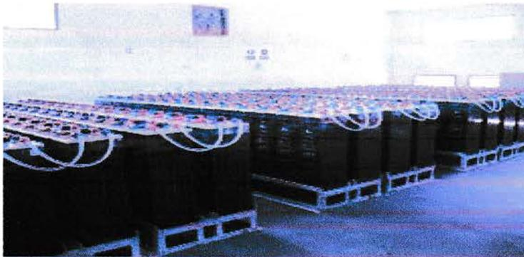
Gambar 2.22 Baterai Untuk supplay Panel Control GI
