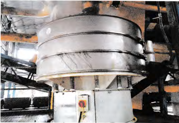
Gambar:4.9. Soico (Penyaring Minyak)
