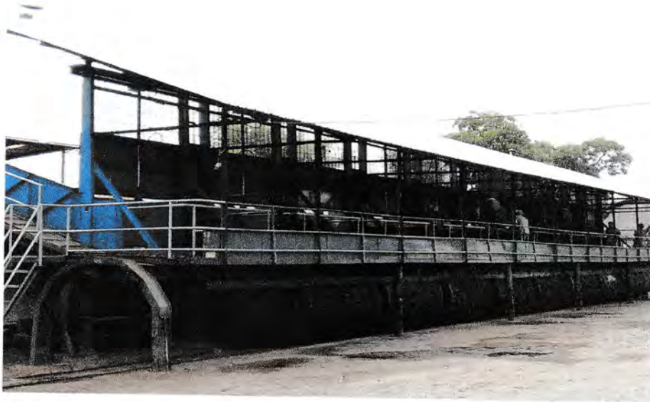
Gamba:4.3. Loding Ramp
