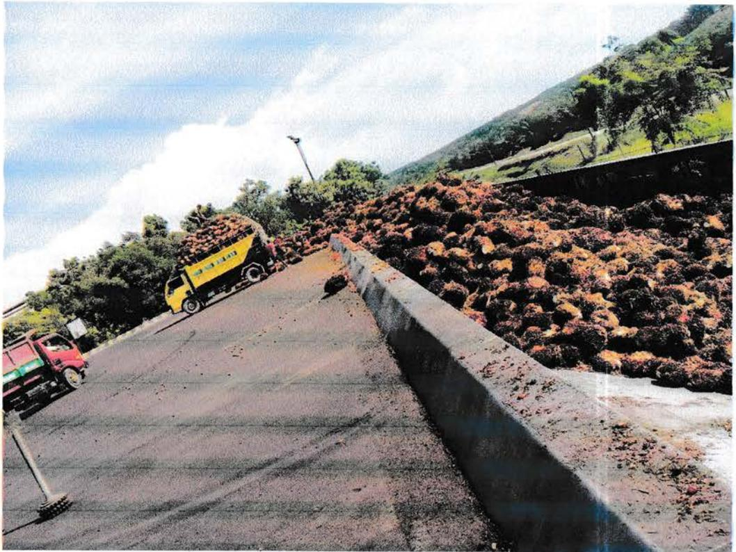
*Gambar: Loading Ramp Pengumpulan TBS*
