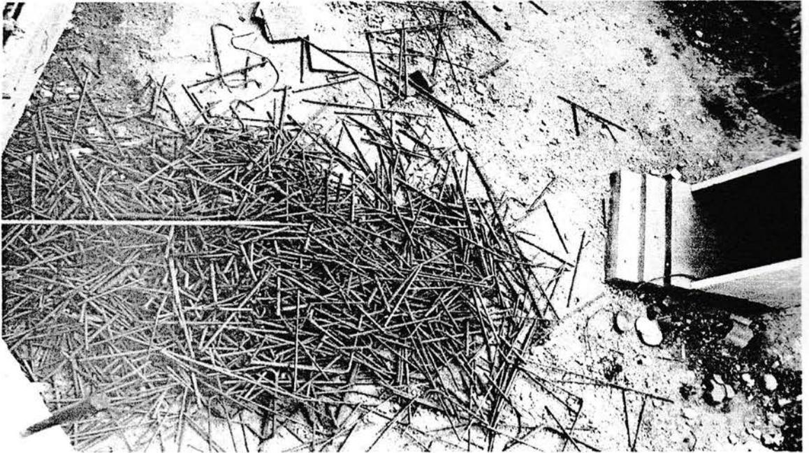
Potongan (puing-puing) dari sisa pemotongan besi
