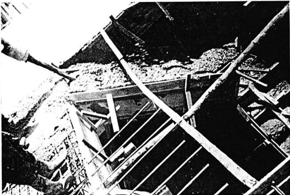
GAMBAR 4 : PENGECORAN TANGGA
