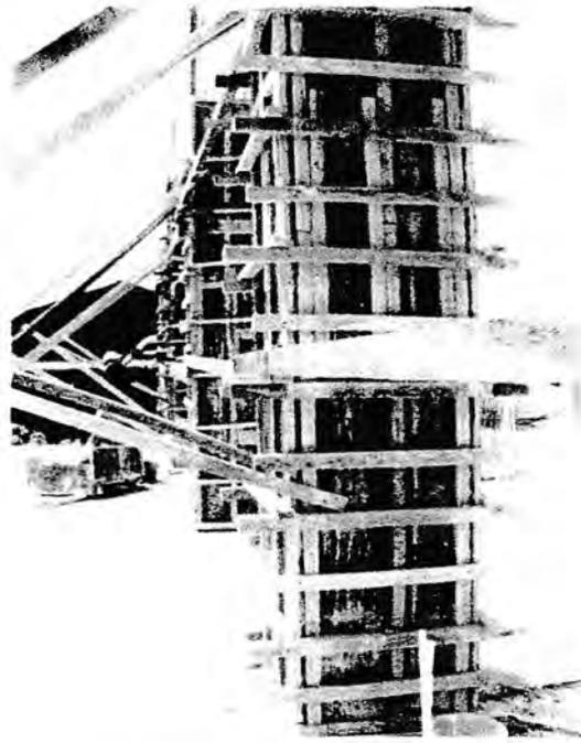
Gambar 2.9 Pemasangan bekisting
