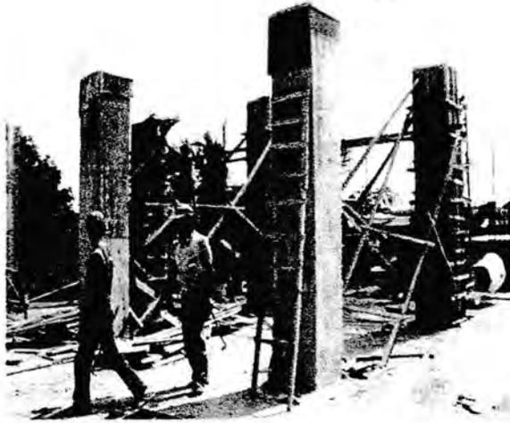
Gambar 2.11 Pembongkaran bekisting
