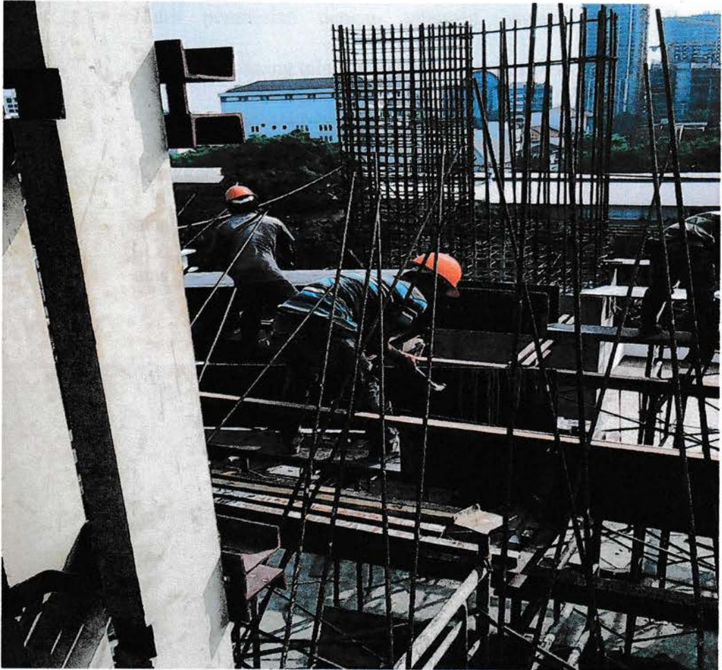
**Gambar 3.13 Pemasangan Bekisting Balok dan Plat Lantai**
