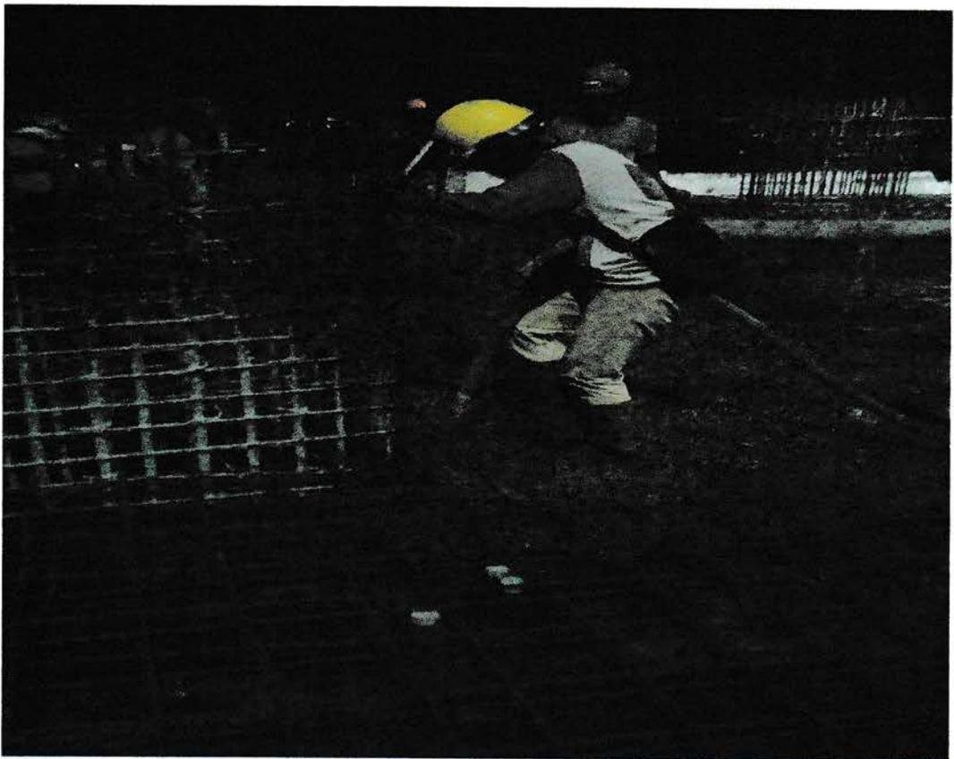
**Gambar 3.15 Pengecoran Plat Lantai**
