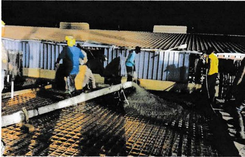
**Gambar 3.9. pekerjaan pengecoran**
