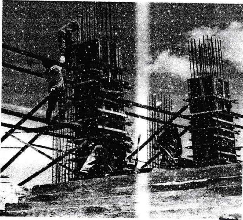
*Gambar 2 :Proses Pengecoran Kolom*
