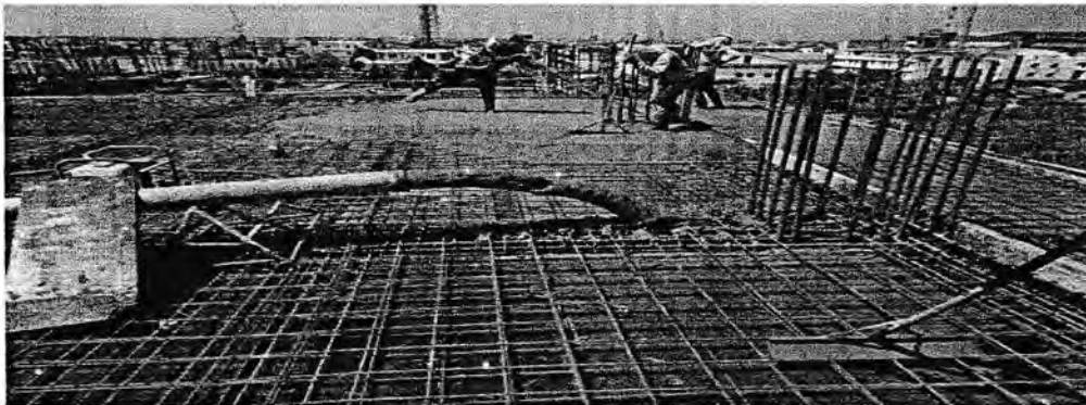
Gambar: 3.1.4 Pengecoran dan pemadatan
