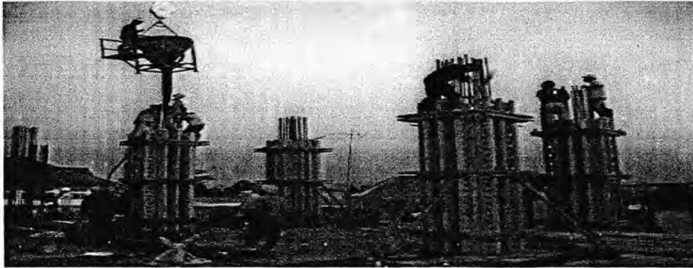
Gambar :3.1.4 Pekerjaan pengangkutan cor beton
