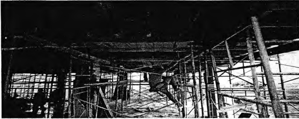
Gambar: 3.1.5 pembongkaran bekisting pada plat lantai
