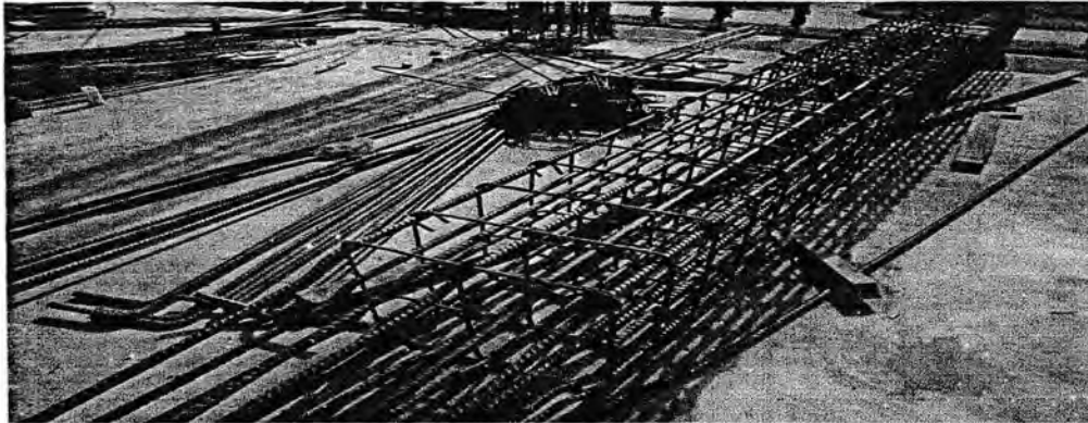
Gambar: 3.1.2. Pekerjaan pemasangan tulangan Kolom
