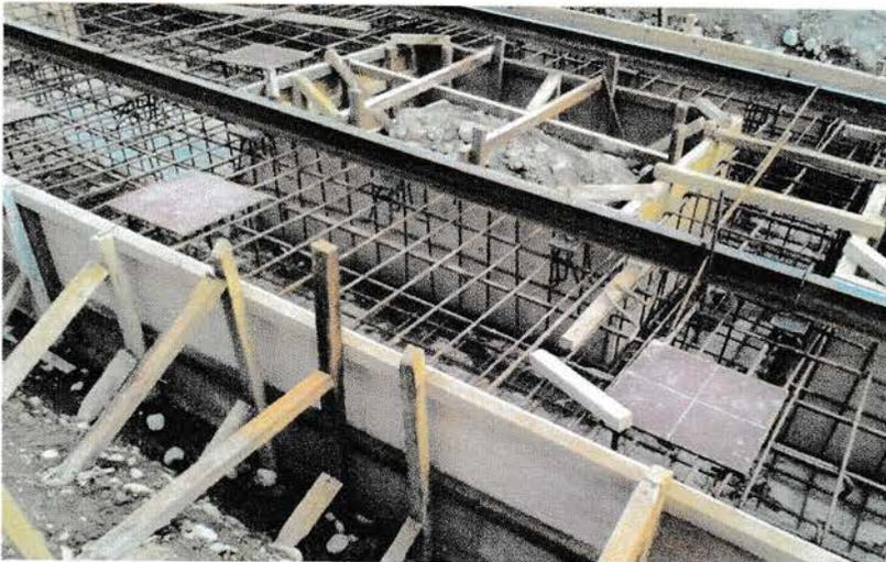
Gambar 2.14 Pekerjaan Pemasangan Base Plate
