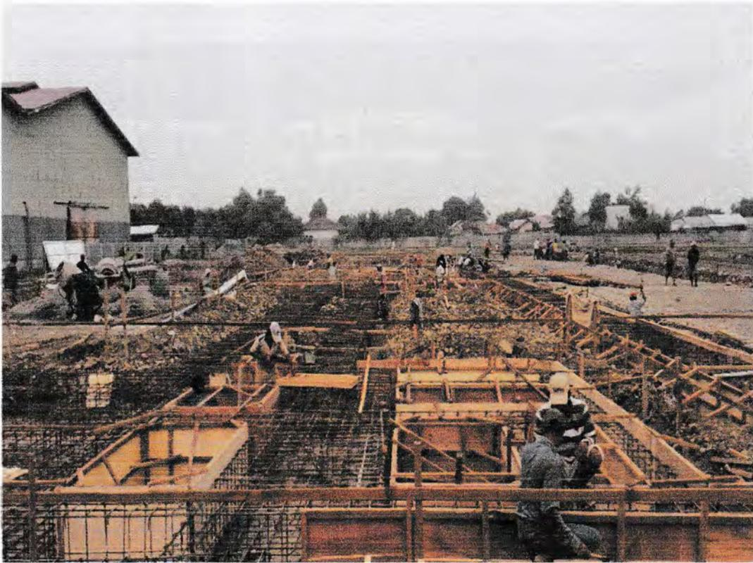
Photo Pekerjaan Pembesian Pondasi Form Work Box Girder
