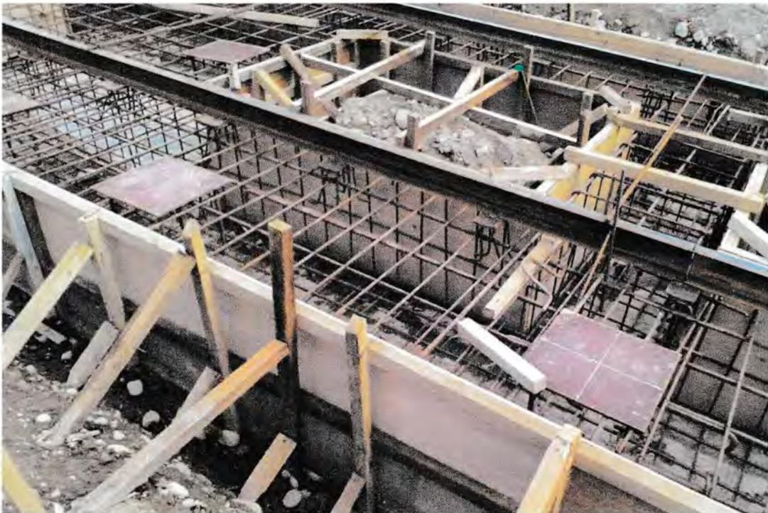
Gambar 2.14 Pekerjaan Pemasangan Base Plate
