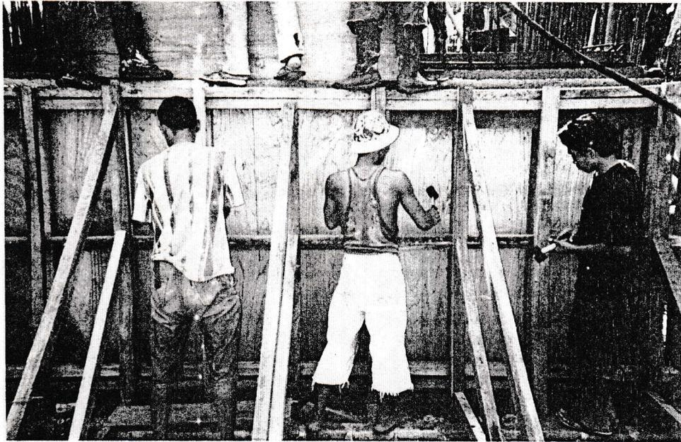
*Bekisting dinding Tahap I di isi beton cor*
