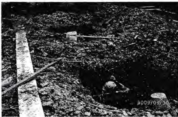
Gambar: pekerjaan galian tanah untuk pondasi
