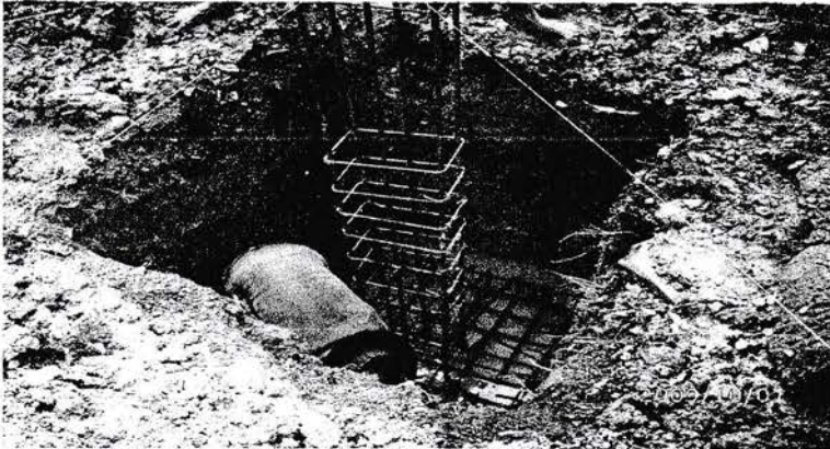
Gambar 5.3 Penulangan pondasi
