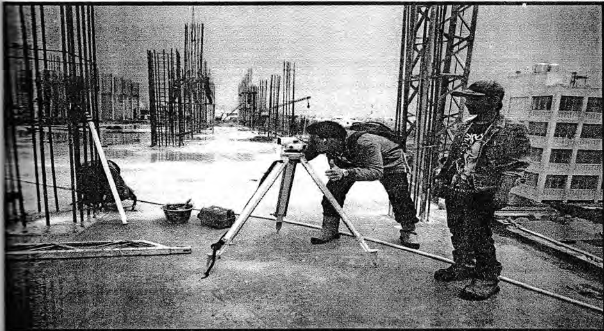
Gambar.. Pengukuran elevasi Lantai Menggunakan Water Pass
