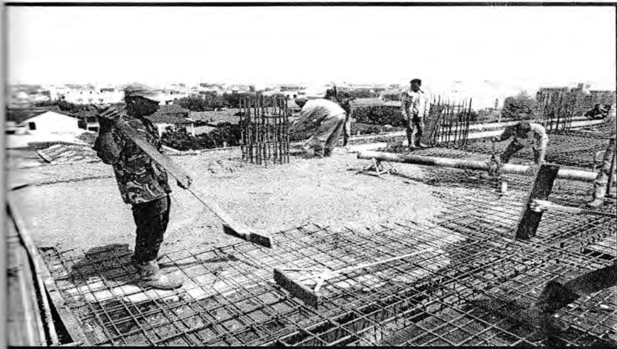
Gambar. Perataan Beton Cor
