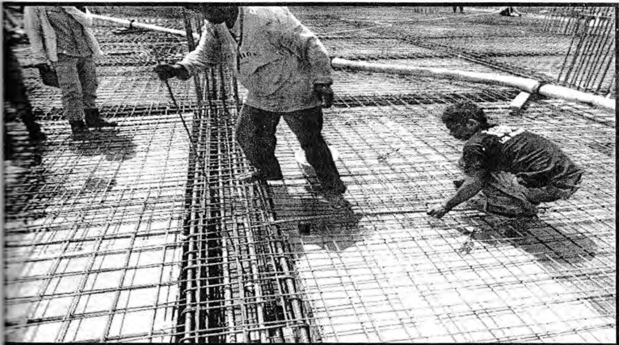
Gambar. Pemasangan Batu tahu
