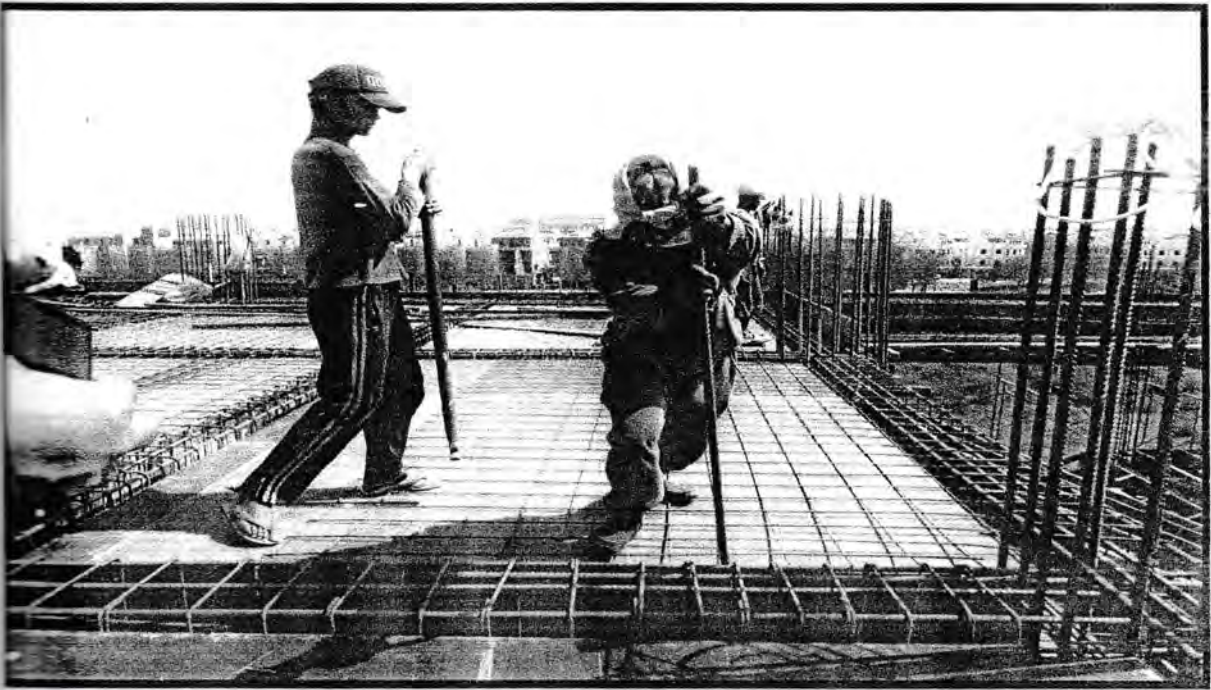
Gambar. Pemasangan Plat Wiremesh
