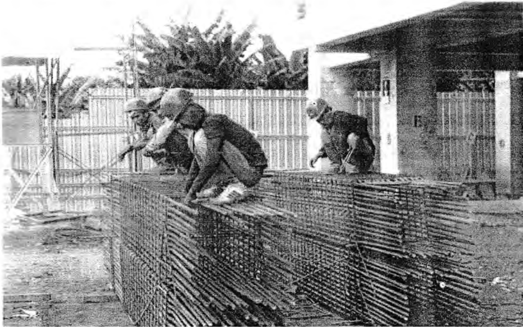
Gambar 2.9.6 Pembuatan Besi tulangan kolom
