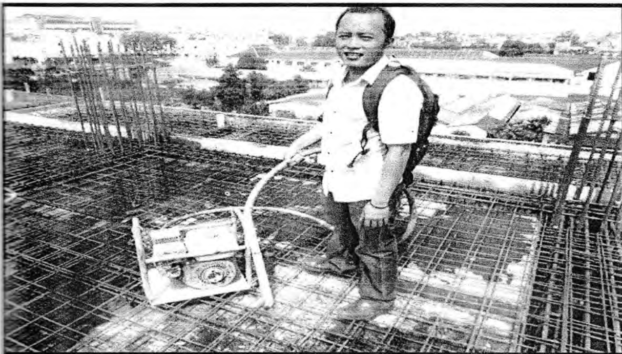
Gambar. Mesin Vibrator Alat untuk Pemadatan Beton
