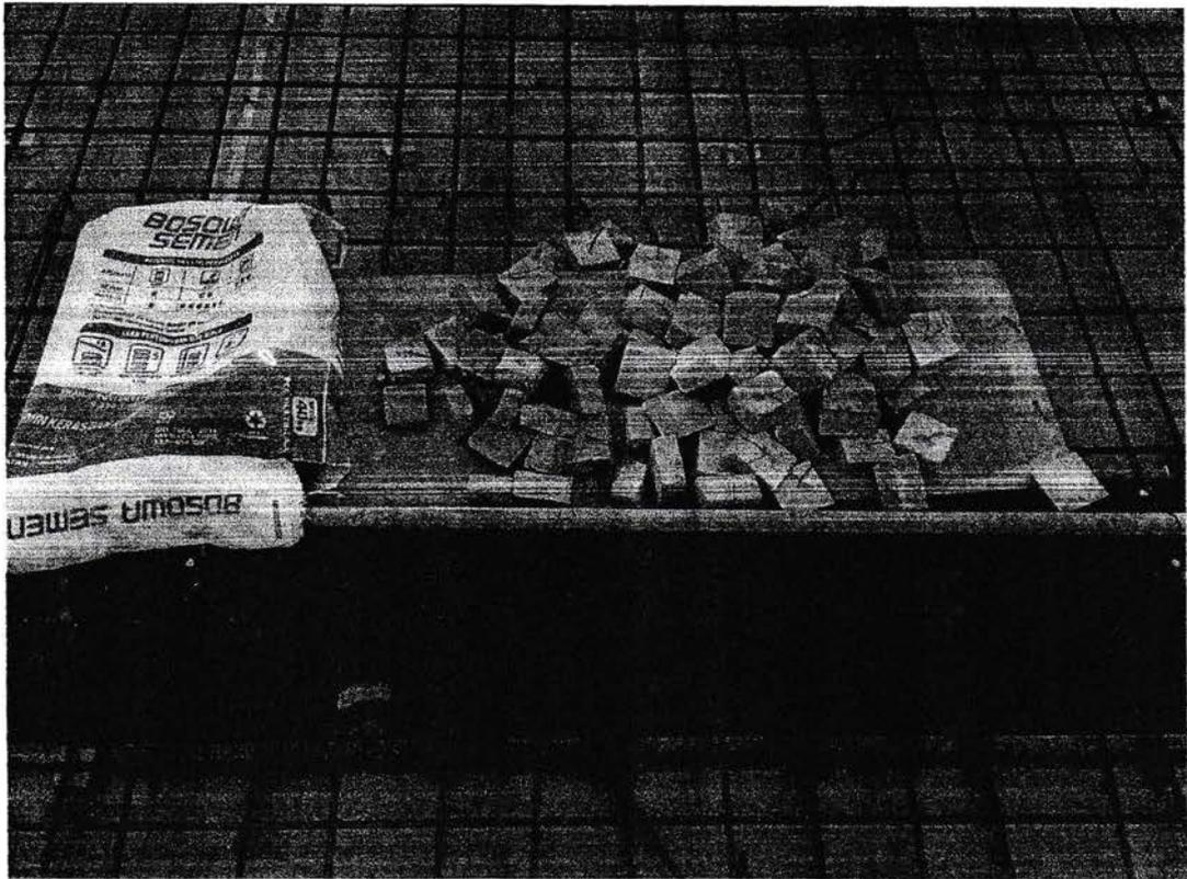
**Gambar 3.8 Beton Decking/TahuBeton**
