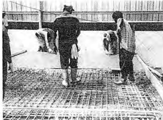
Gambar 3.15 Pengecoran Plat Lantai
