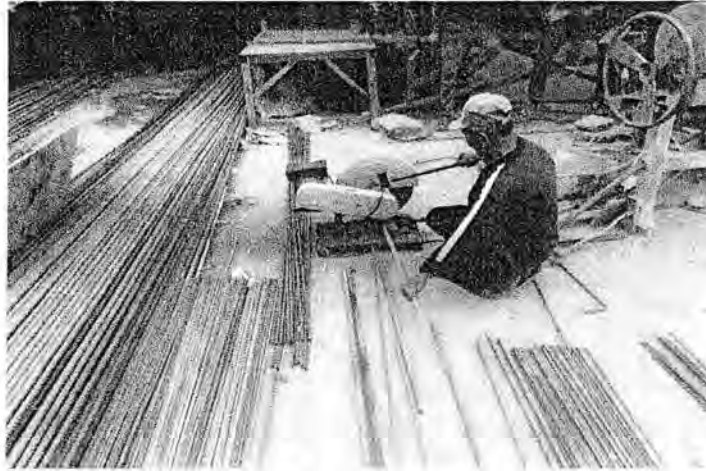
Gambar : Pemotongan Besi Tulangan
