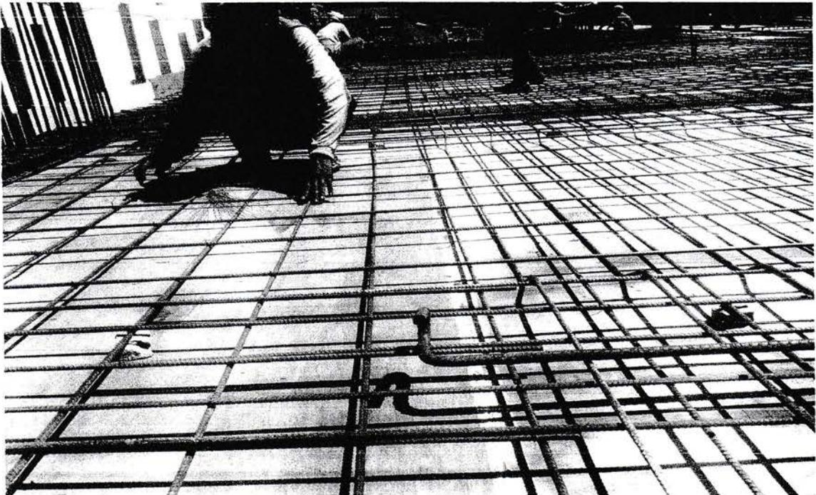
**Gambar 1.10 : Proses pengikatan kawat pada besi-besi plat lantai**
