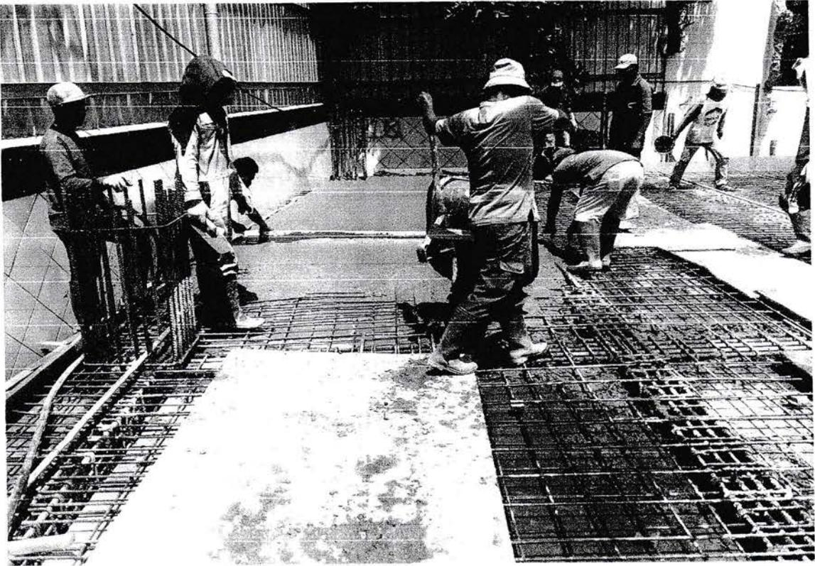
**Gambar 1.15 : Proses pekerjaan pengecoran pada plat lantai**
