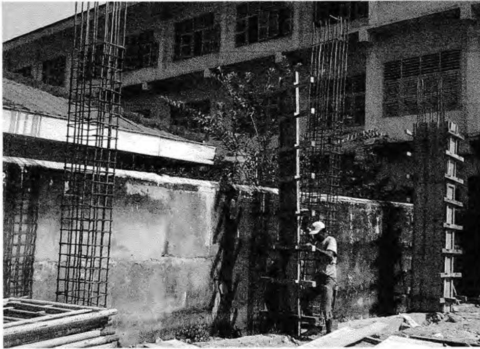
Gambar 9 : Pembesian Kolom dan Pemasangan Bekisting Gedung
