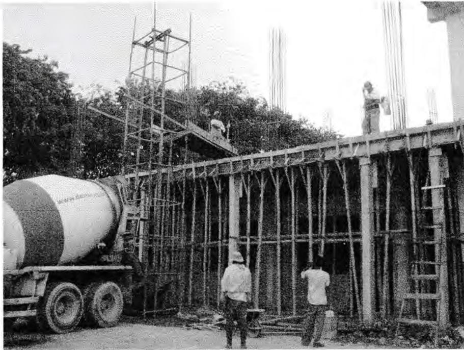
Gambar 13 : Pengecoran Gedung menggunakan Lift Beton
