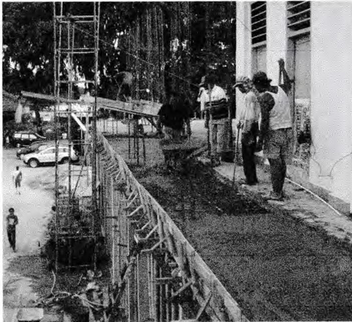
Gambar 5 : Pengecoran lantai 2
