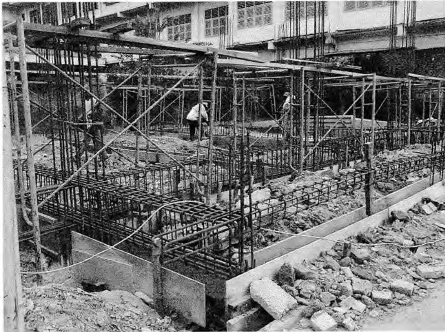
Gambar 3 : Pemasangan Bekisting & Tulangan
