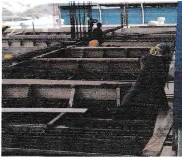
Gambar 3.14 penulangan balok
