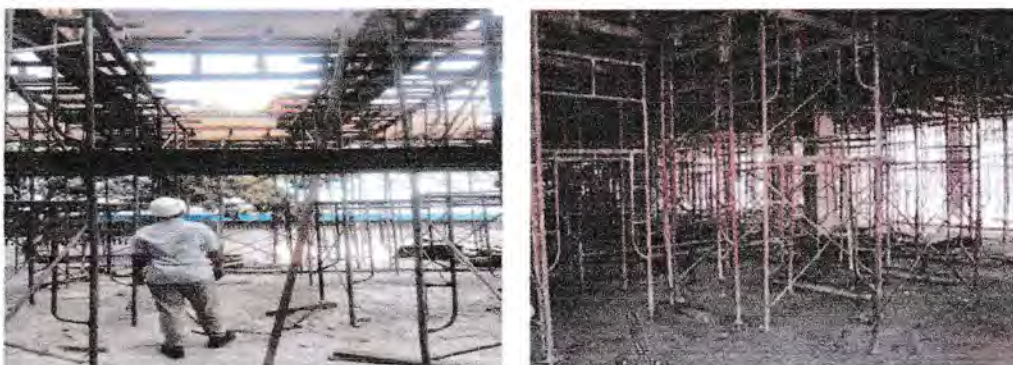
Gambar 3.19 Pemasangan Scaffolding Pada Pembekistingan Balok
