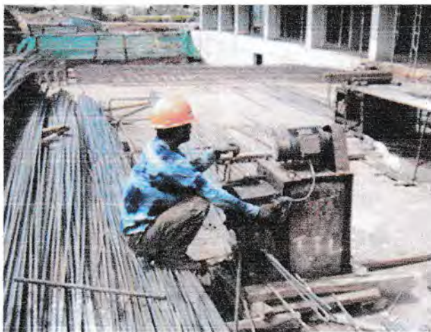
Gambar 3.18 Pemotongan Besi
