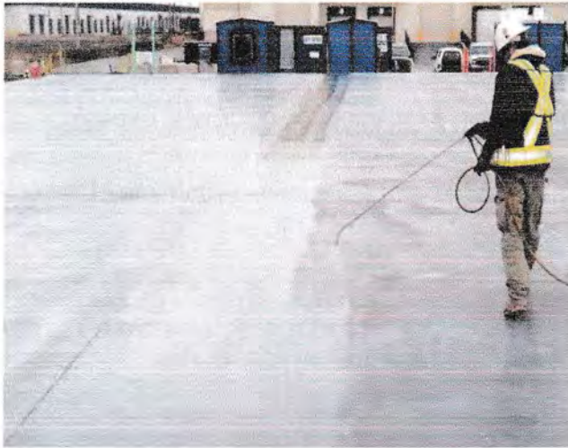
Gambar 3.23 Penyiraman Pada Beton Setelah Pengecoran
