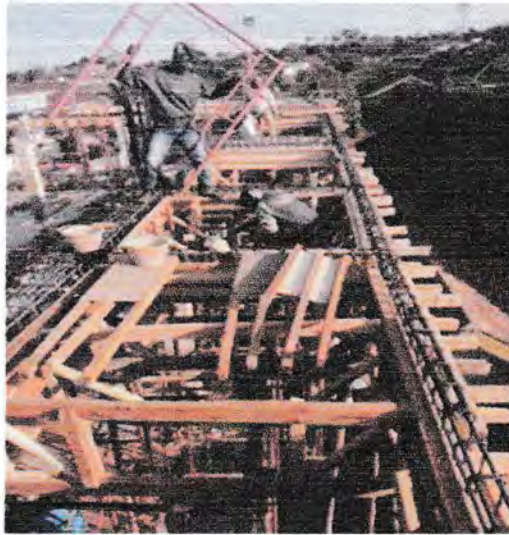
Gambar 3.17 Pembuatan Bekisting
