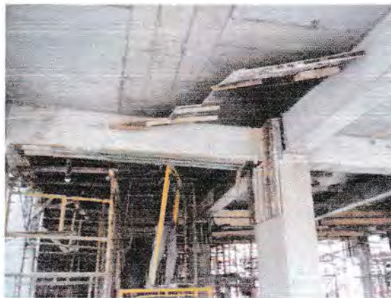
Gambar 3.22 Pembongkaran Bekisting Balok
