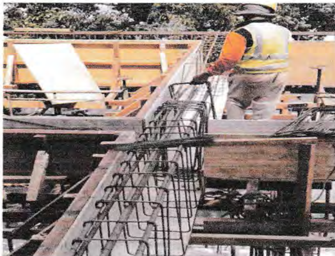
Gambar 3.20 Pembesian Balok
