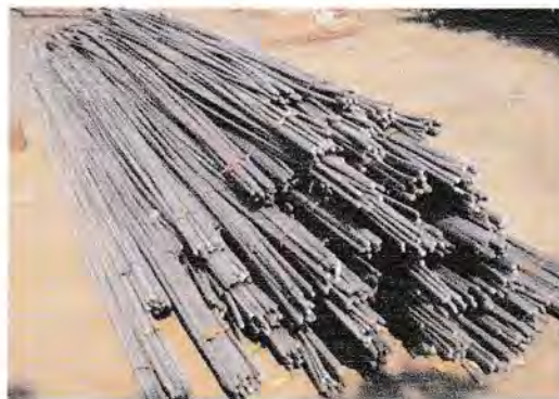
gambar 3.12 Besi Tulangan Sumber: Dokumentasi lapangan
