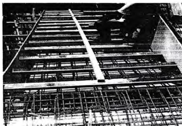
Gambar.3.2.5.4 Pemasangan Bekisting Tangga
