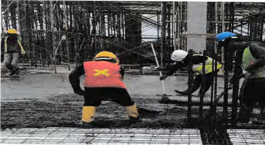
**Gambar 3.22 Pekerjaan Pengecoran Balok dan Polat Lantai**
