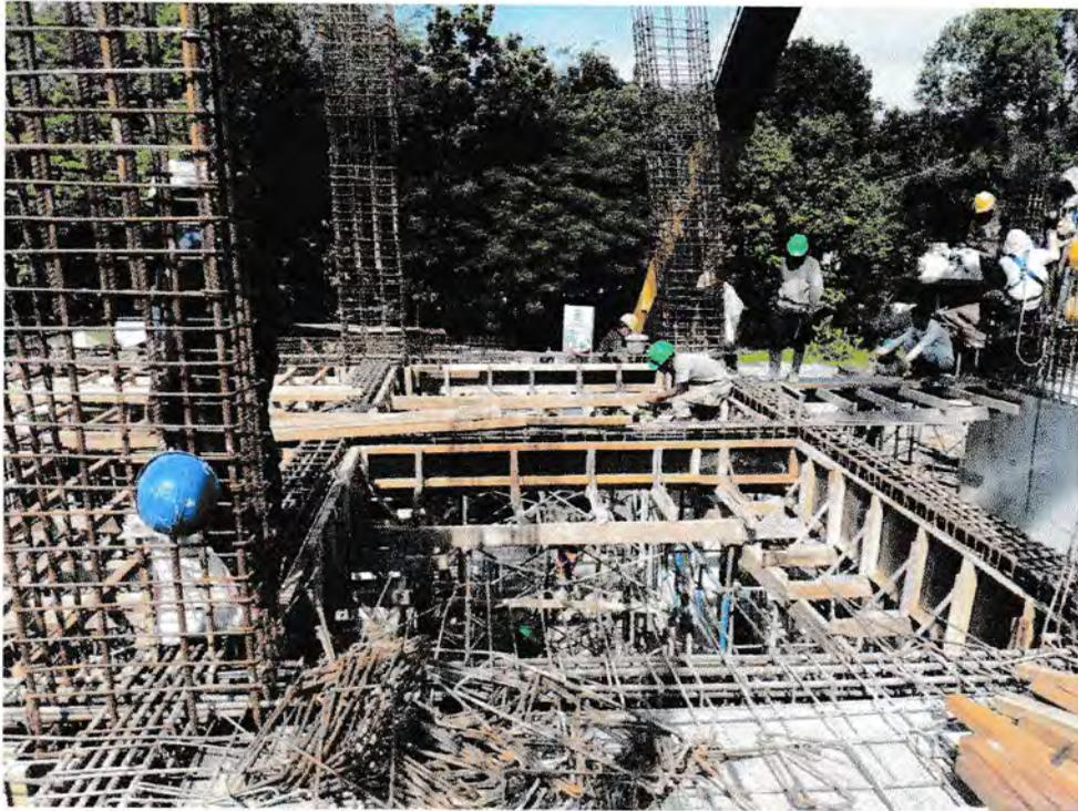
Gambar: Kondisi Penulangan Balok Pada Lantai 2
