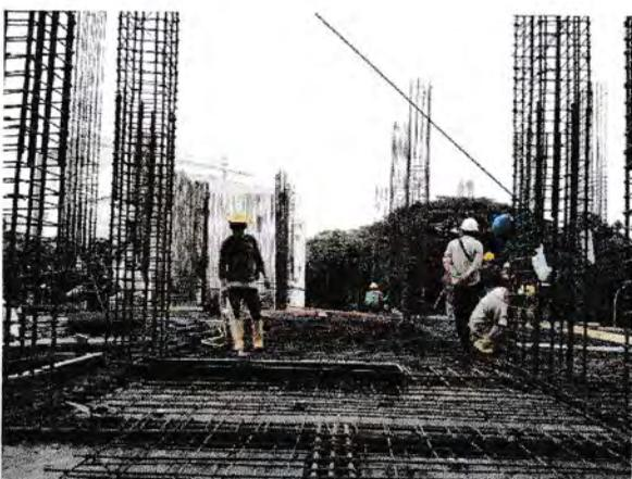
Gambar : Pembersihan Sebelum Pengecoran
