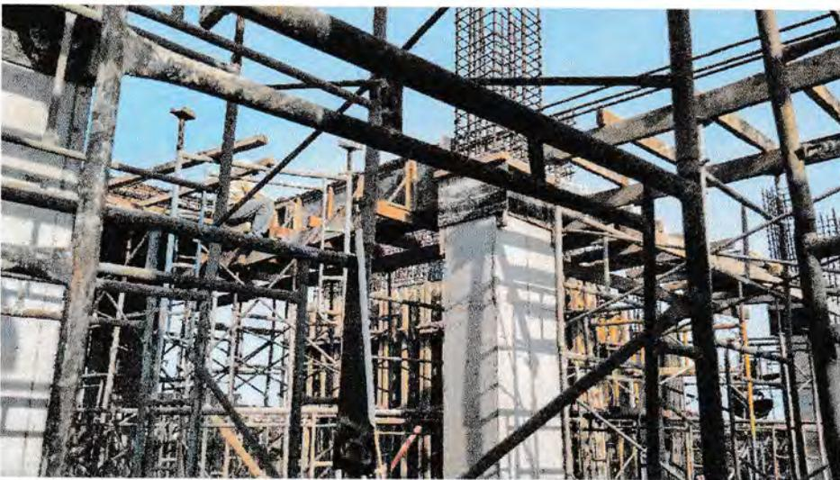
**Gambar 3.20 Pekerjaan Bekisting Balok**
