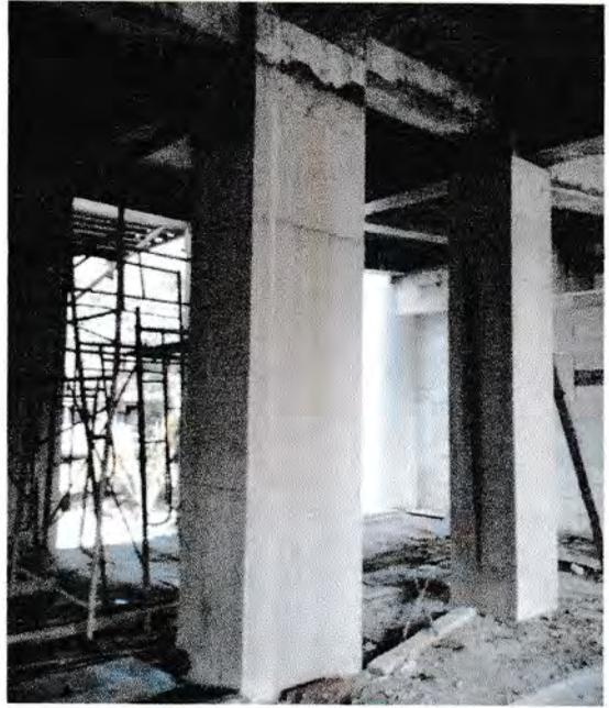
Gambar : Kolom yang sudah dibuka bekisting
