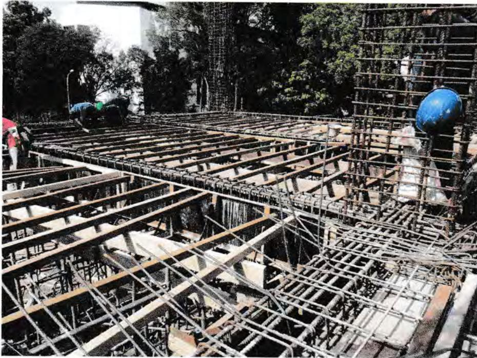
**Gambar 3.21 Pekerjaan Pembesian Balok**
