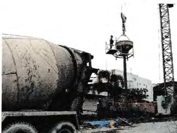
Gambar: Pengecoran Dengan Pipa Tremie
